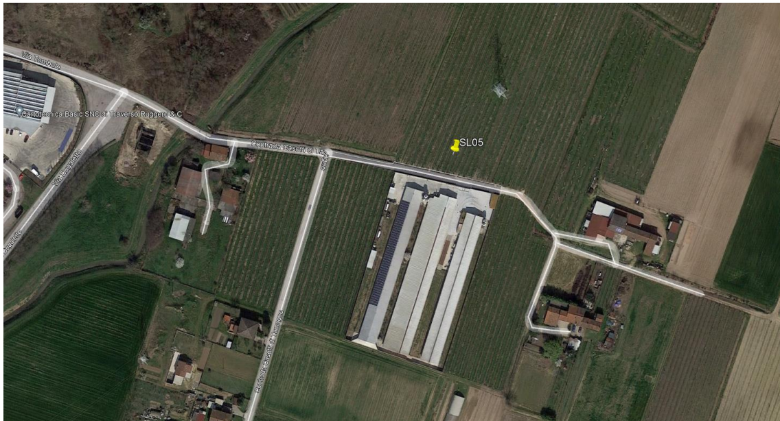
Figura 1: Stato di fatto
