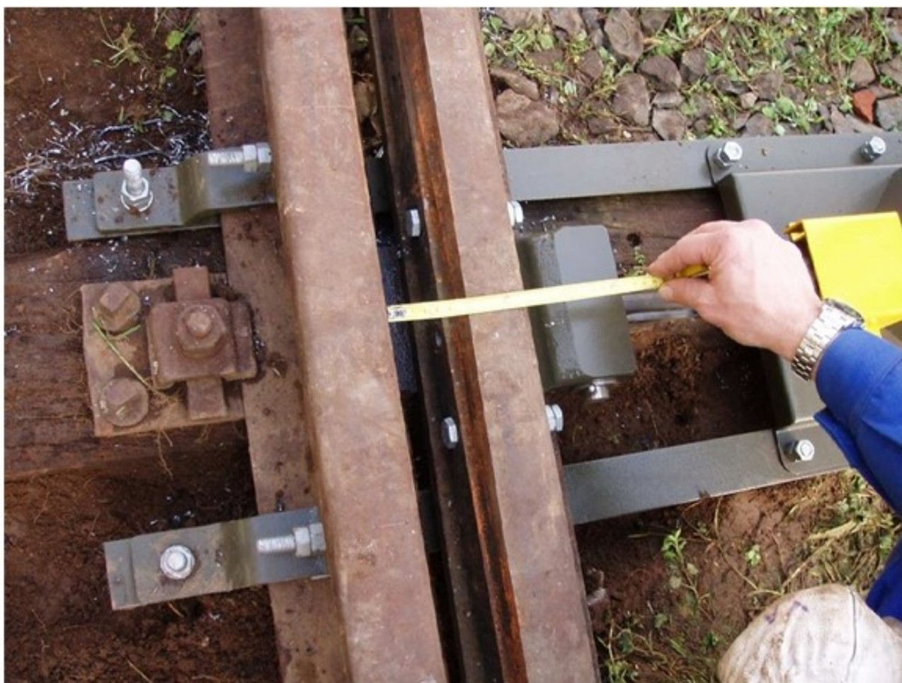
Foto 13 – Regolazione della corsa del DCF
