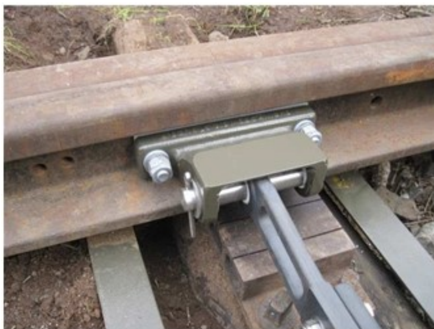
Foto 12 – Montaggio della zampa d'attacco all'ago
