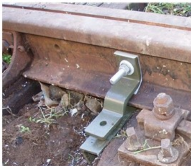
Foto 8 – Montaggio staffe con isolanti
