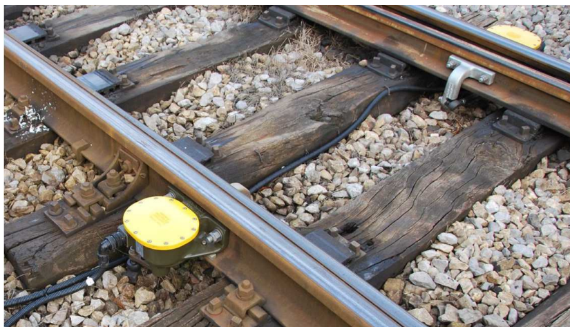
Foto 17 - Montaggio Scatole di controllo sui contraghi
