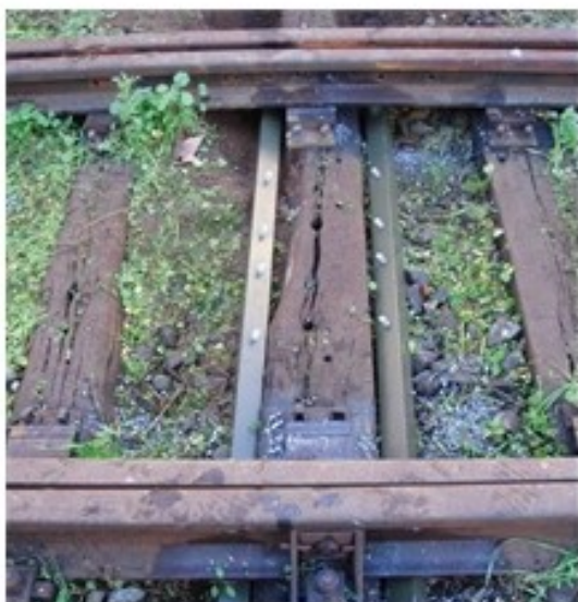
Foto 7 – Posizionamento zatteroni
