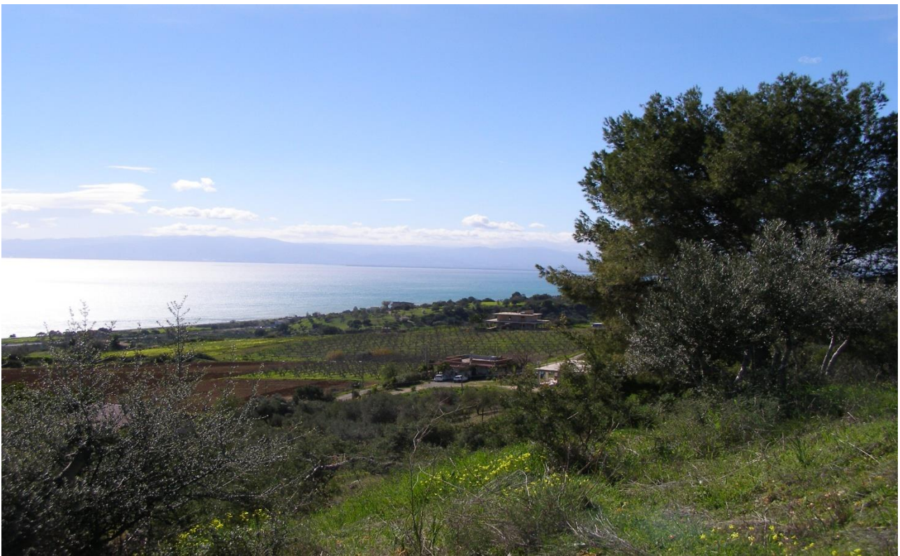
Terrazze Rovitti: Preliminare tutto in galleria naturale profonda Definitivo trincea lunghezza 863 m.
