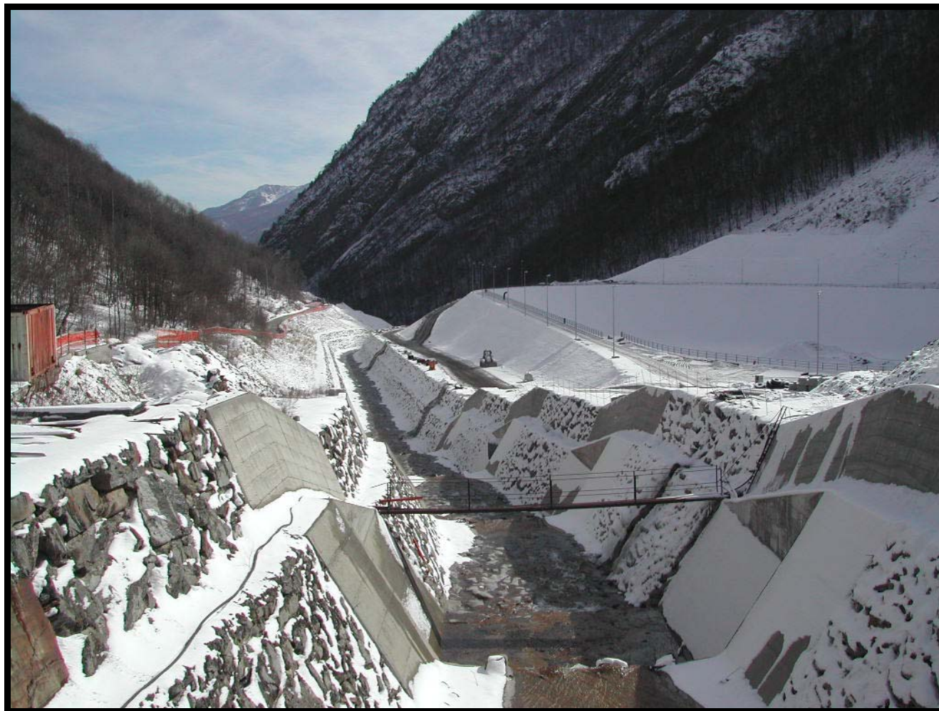
Foto 8 – Rio Clarea verso valle: sono evidenti le opere di regimazione del corso d’acqua e, sulla destra, il perimetro della vasca di accumulo (riconoscibile per la presenza di una strada di servizio completata da pali per l’illuminazione).
