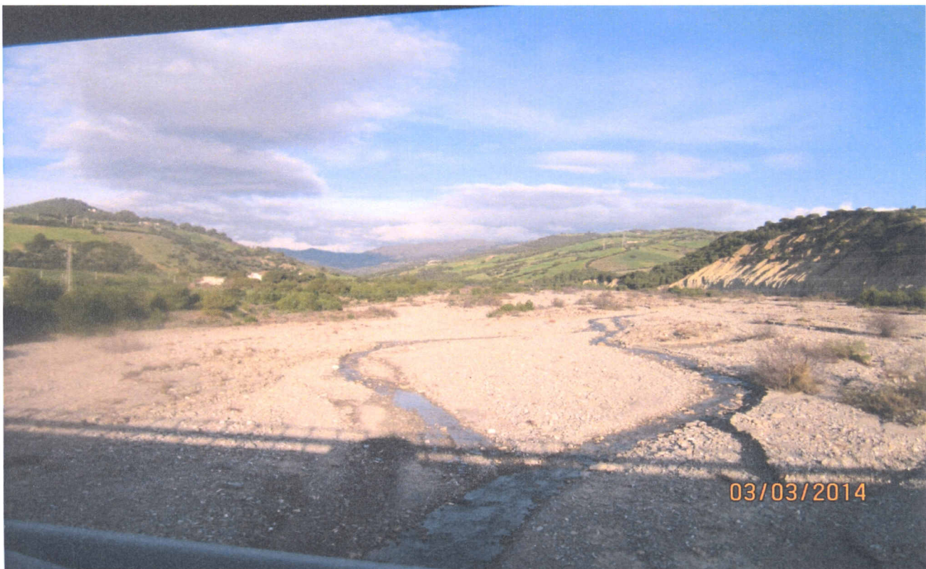
Torrente Avena: prog. Def. viadotto lung 695 m h 84 m -prog. Prelim. viadotto lung 362 m h 18 m
