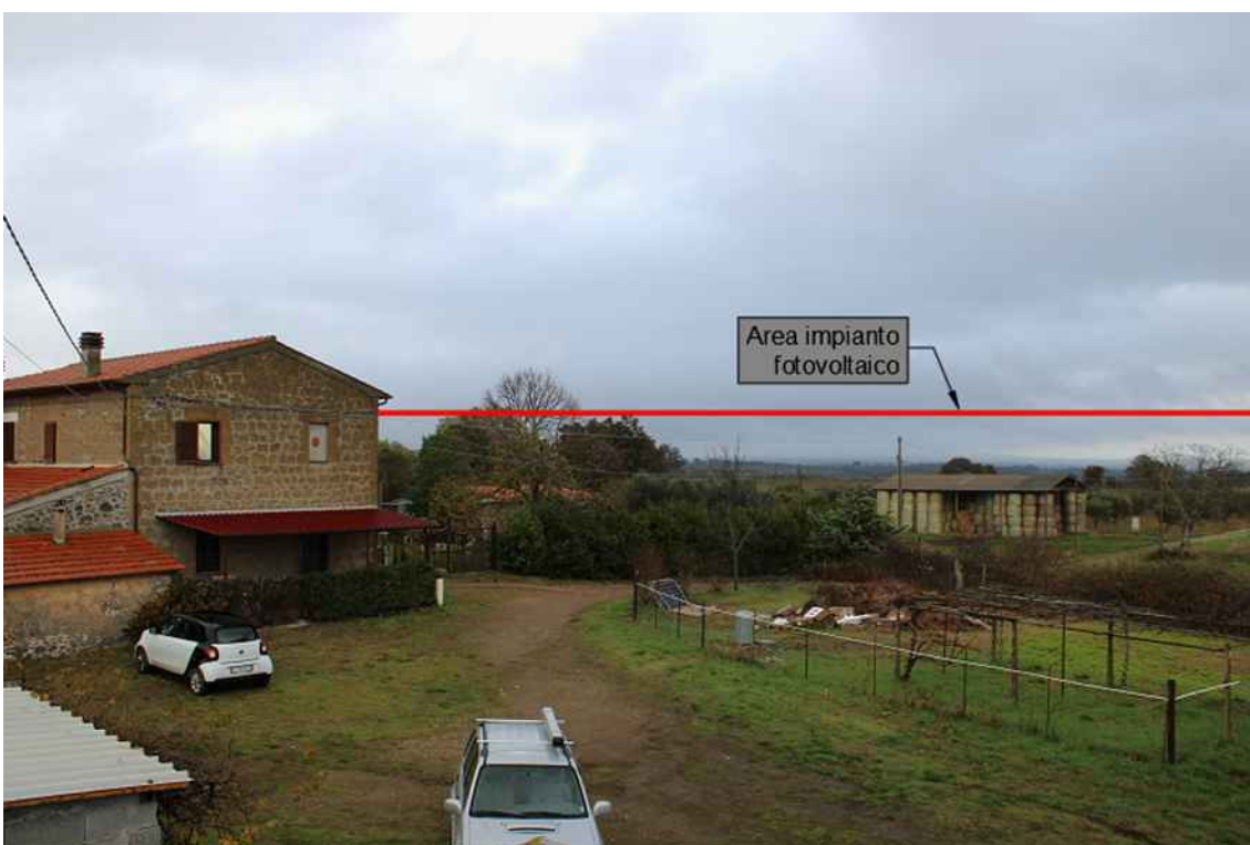
FOTO 1 – ABITAZIONE “E1” Con indicazione dell’area di impianto
