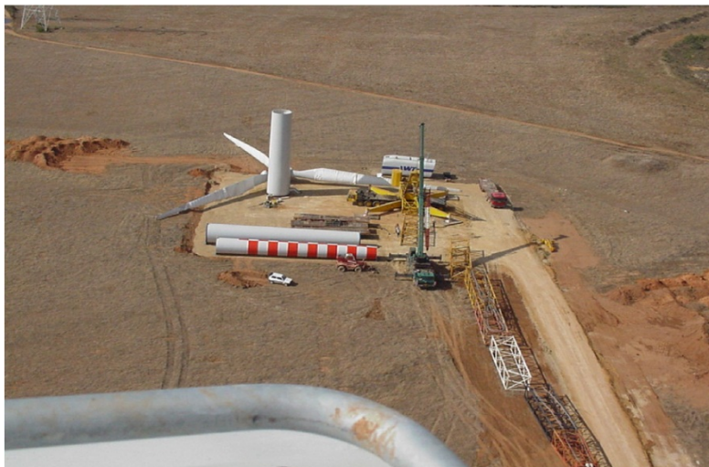
Figura 15 – Piazzola per il montaggio dell'aerogeneratore
