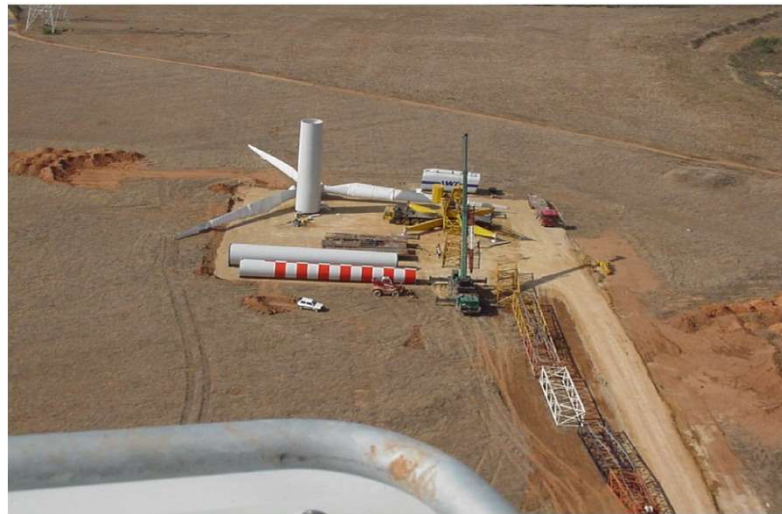
Figura 2 – Piazzola per il montaggio dell'aerogeneratore
