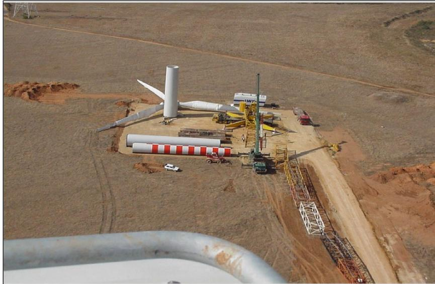
Figura 4 - Piazzola per il montaggio dell'aerogeneratore
