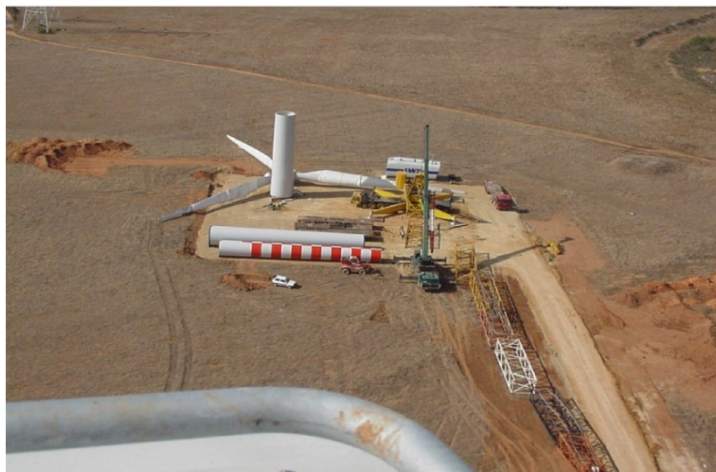
Figura 41 – Piazzola per il montaggio dell'aerogeneratore
