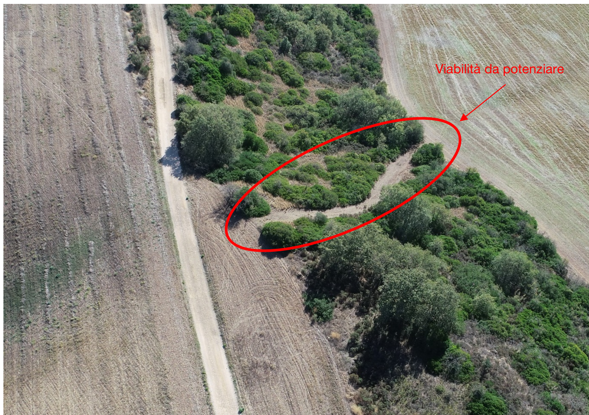
Figura 7 - Viabilità da potenziare di accesso all'aerogeneratore RGT 12
