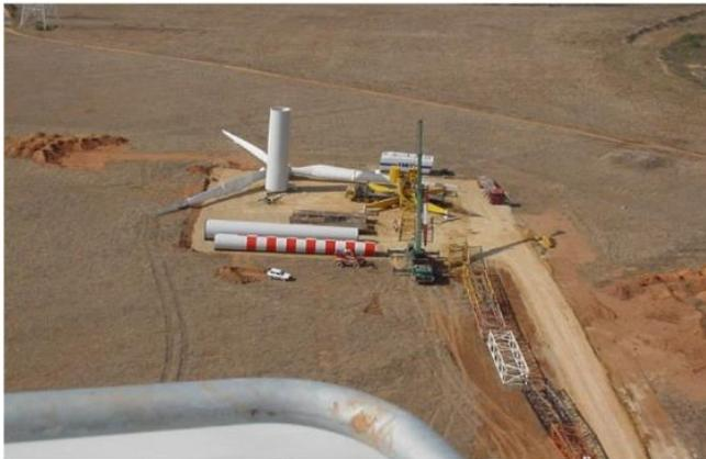
Figura 26 – Piazzola per il montaggio dell’aerogeneratore
