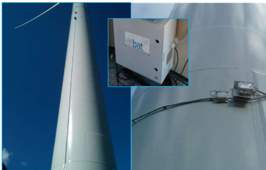
Figura 8 – Esempio di installazione di un sistema automatico su aerogeneratore per abbassare il rischio collisione
