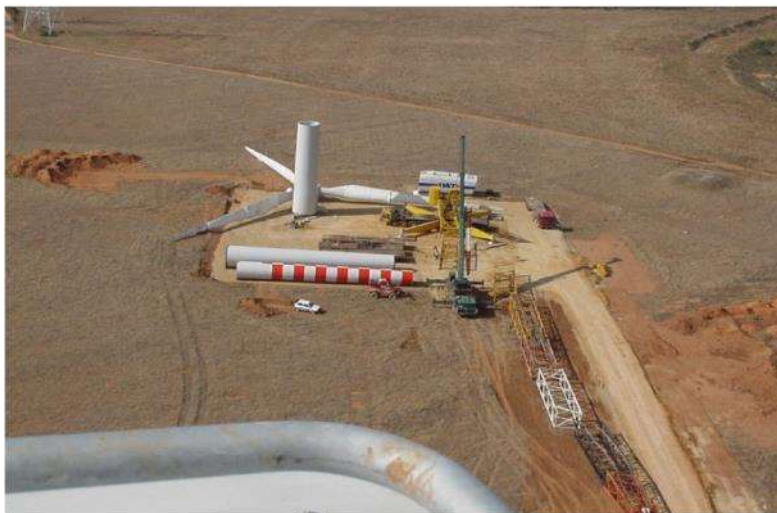
Figura 4 – Piazzola per il montaggio dell'aerogeneratore
