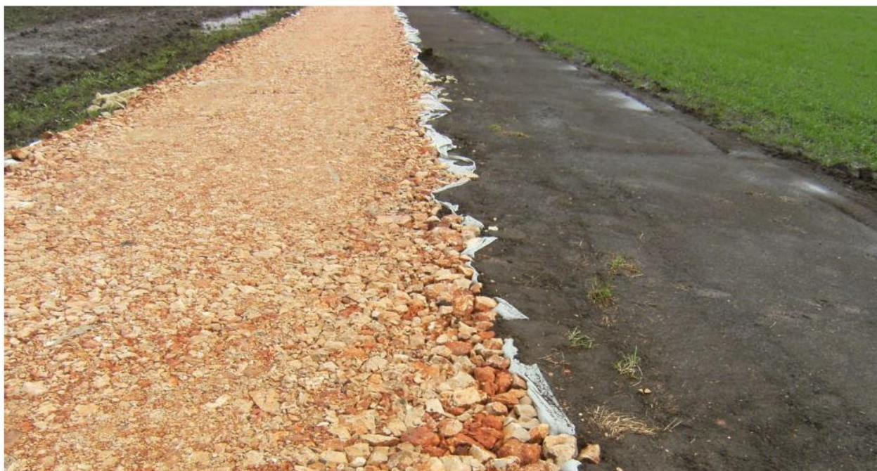
Figura 7-Dettaglio costruzione viabilità interno con terreno stabilizzato
