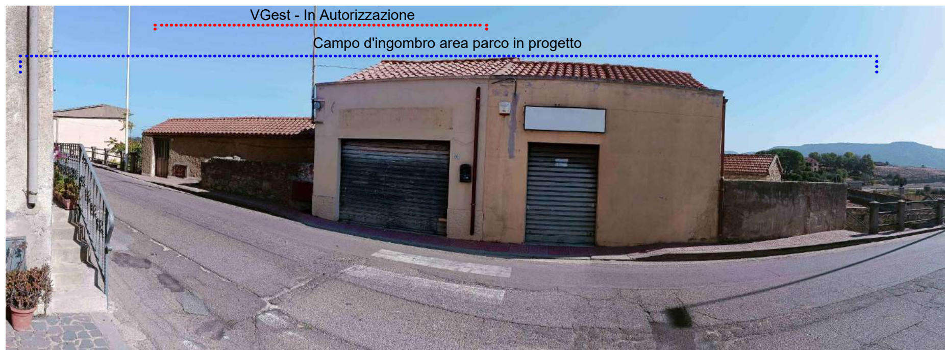
US 3 - CASA IN VIA ELEONORA D'ARBOREA_Ante e post Operam (Comune di Usellus)
