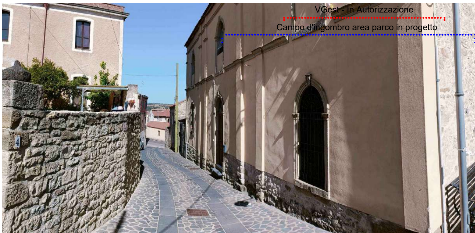
US 1 - CASA MINNEI_Ante e post Operam (Comune di Usellus)
