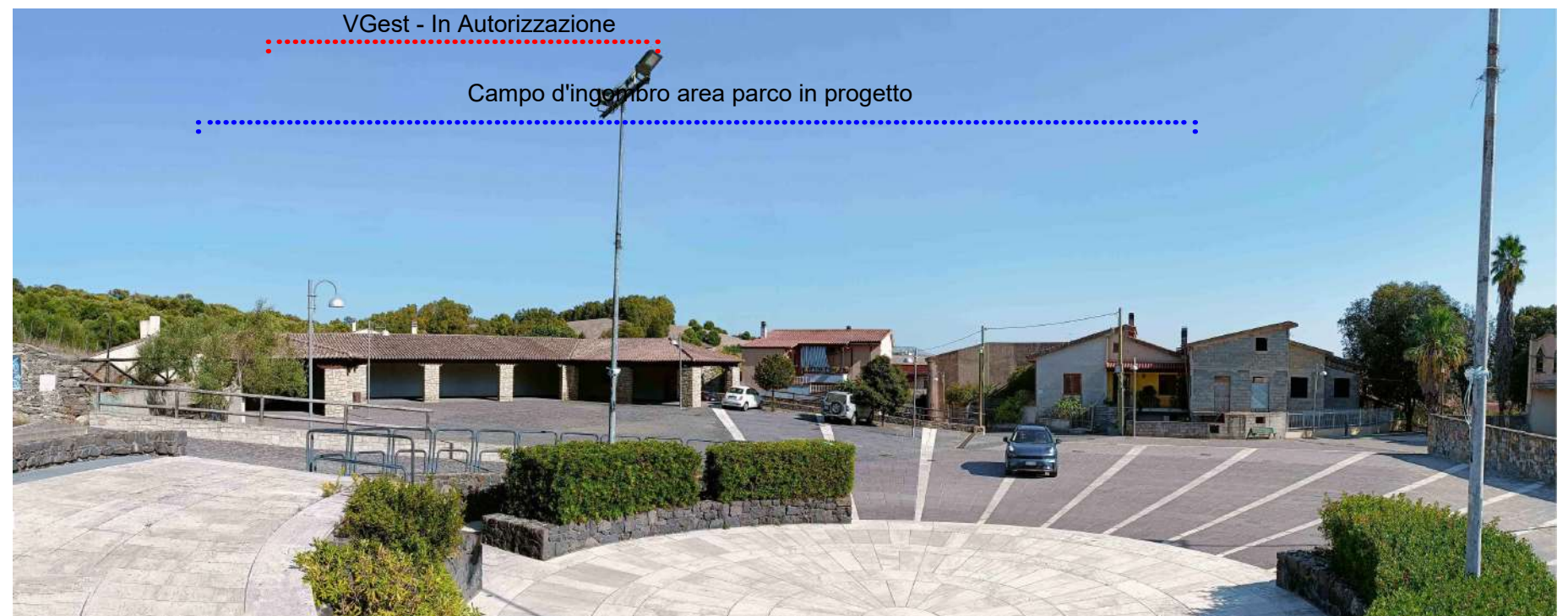
AL 5 - CHIESA DI S. MARIA E LIMITE URBANO_Ante e post Operam (Comune di Ales)
