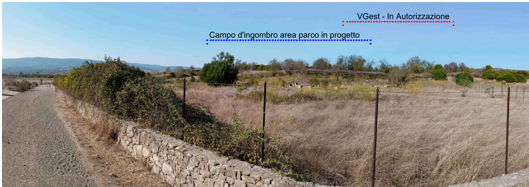
GON 1 - POZZO SACRO DI SAN SALVATORE_Ante e post Operam (Comune di GONNOSNÒ)
