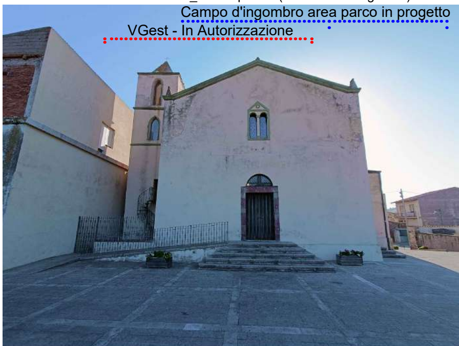
VILLAUUR 1 - CHIESA DI S. MARGHERITA E MUNICIPIO_Ante e post Operam (Comune di Villaurbana)
