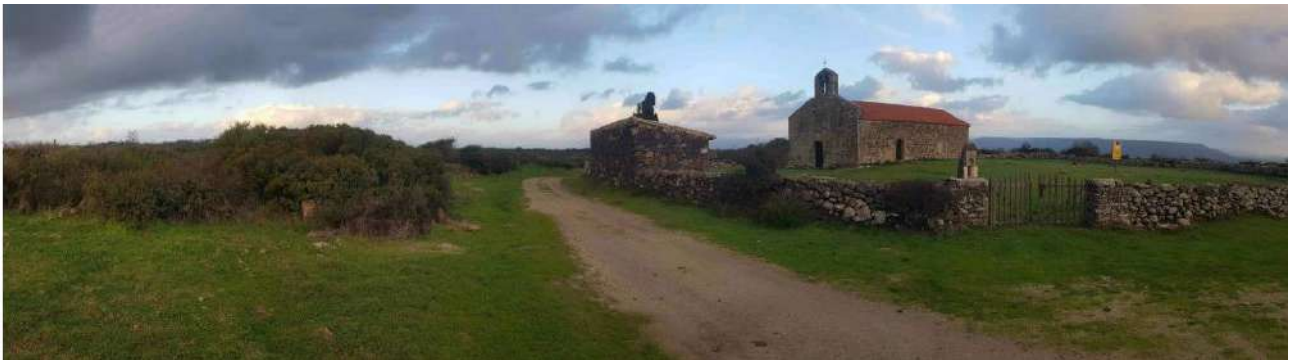
Figura 37: stato dei luoghi ex ante l'intervento
