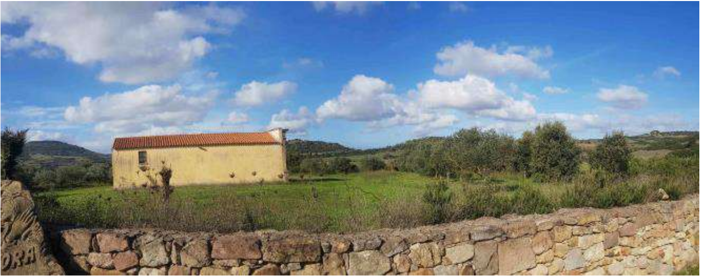
Figura 124: stato dei luoghi ex ante ed ex post l'intervento
