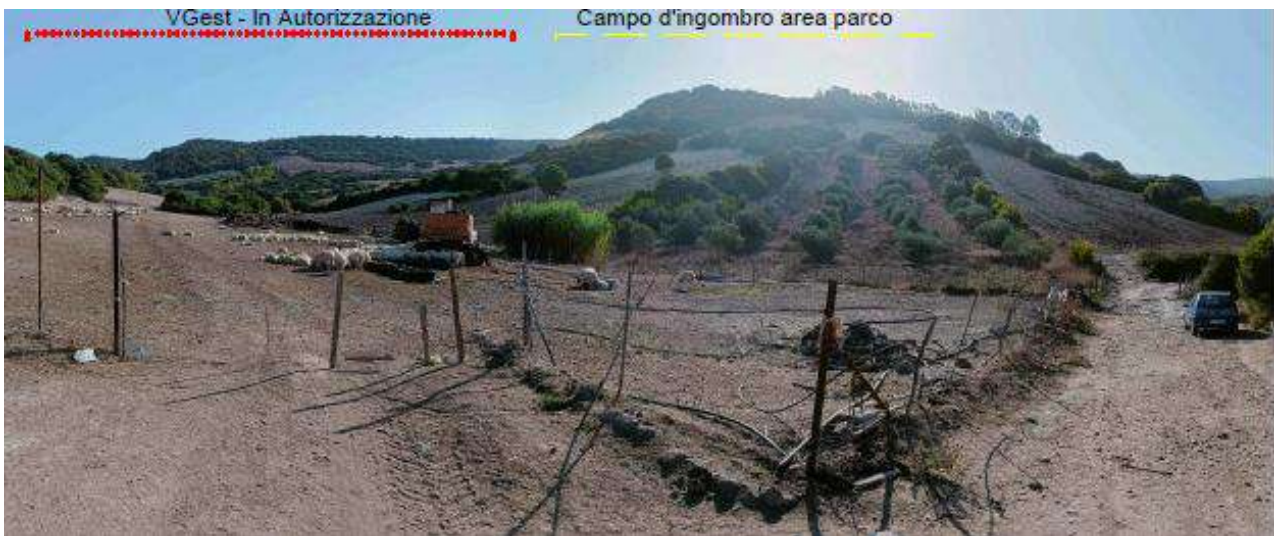
Figura 206: stato dei luoghi ex ante ed ex post l'intervento
