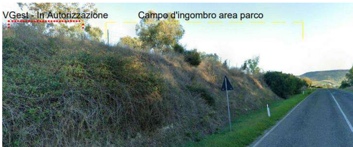
Figura 191: stato dei luoghi ex ante ed ex post l'intervento
