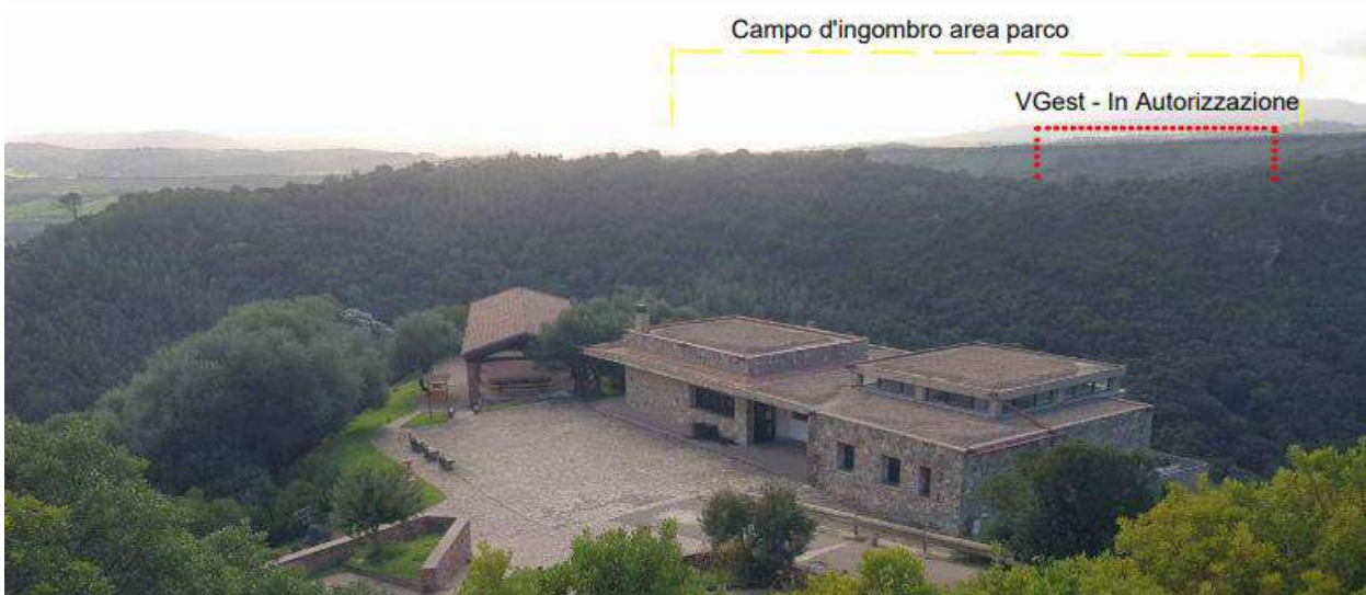
Figura 158: stato dei luoghi ex ante ed ex post l'intervento
