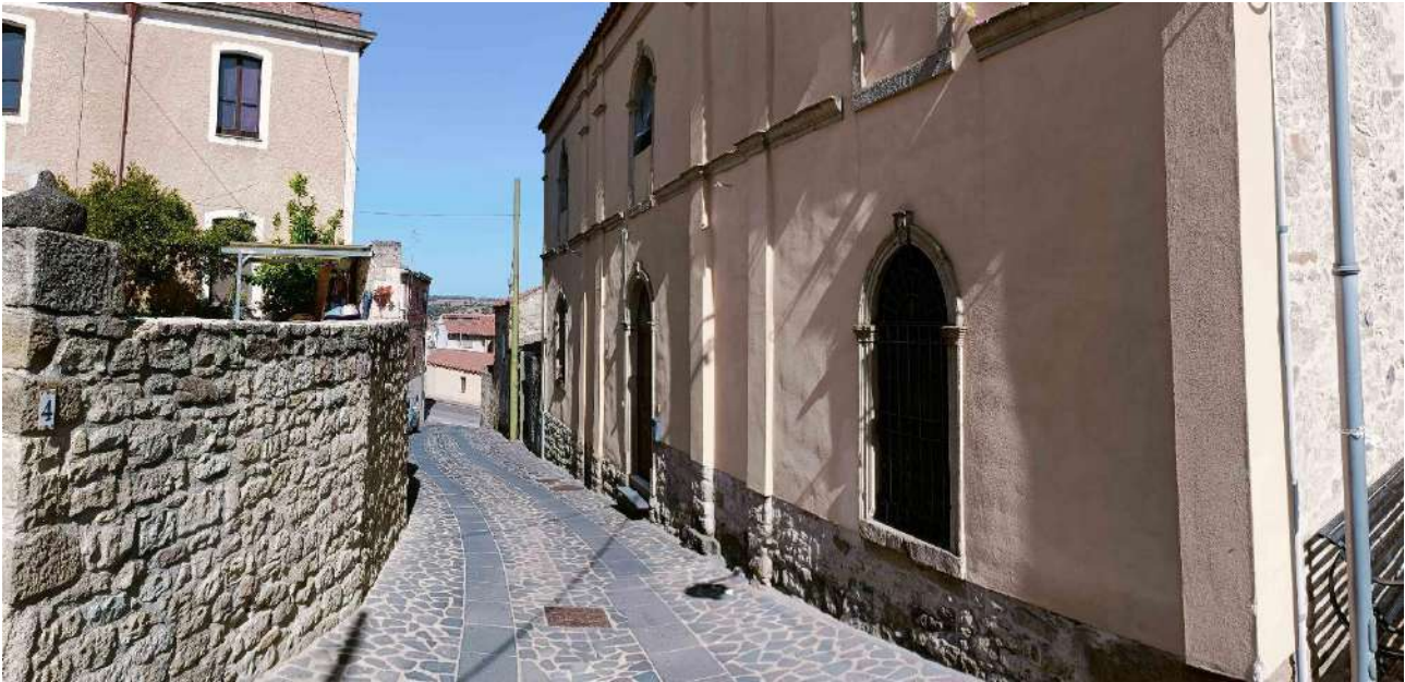
Figura 24: stato dei luoghi ex ante ed ex post l'intervento
