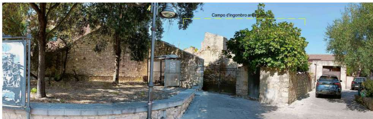
Figura 42: stato dei luoghi ex ante ed ex post l'intervento
