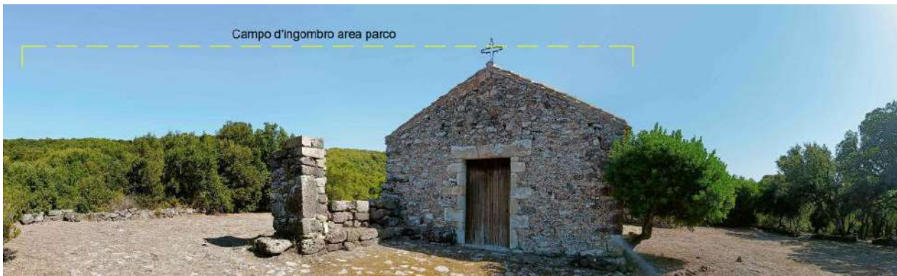
Figura 48: stato dei luoghi ex ante ed ex post l'intervento
