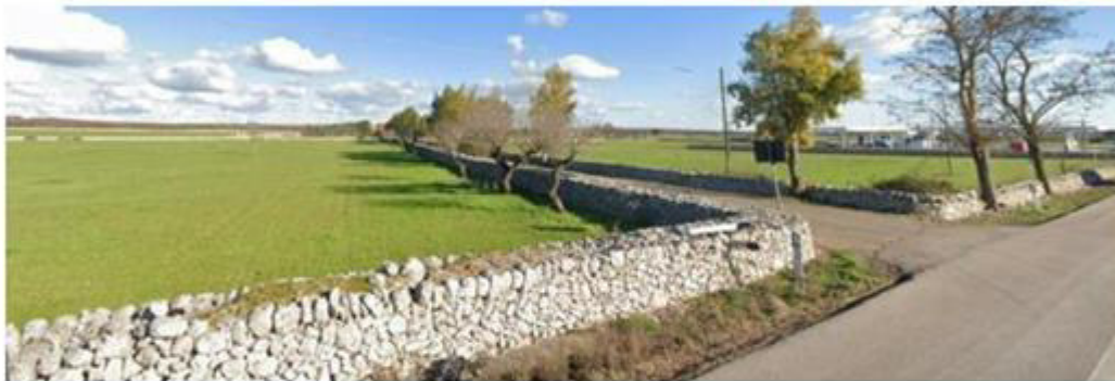
Foto 12 – Muretti a secco lungo la SS100 (Fonte Google Maps)
