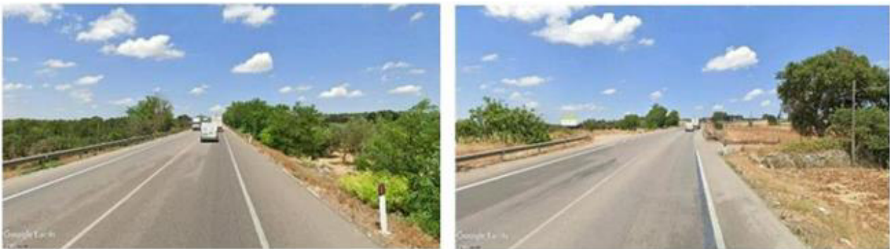
Figura 4-7 e 8: scarpate non protette e terminale pericoloso, immissione non segnalate ne protette
