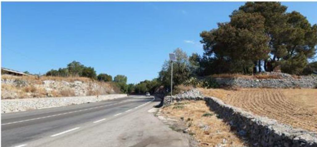
Foto 13 – Muretti a secco lungo la SS100 (Fonte Google Maps)
