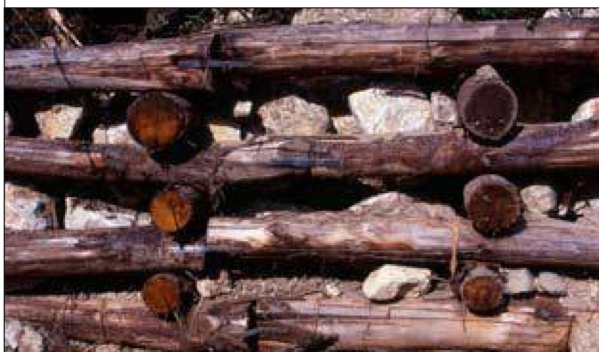
Realizzazione palificata con pietrame a vista (Palificata viva doppia di versante, post operam)
