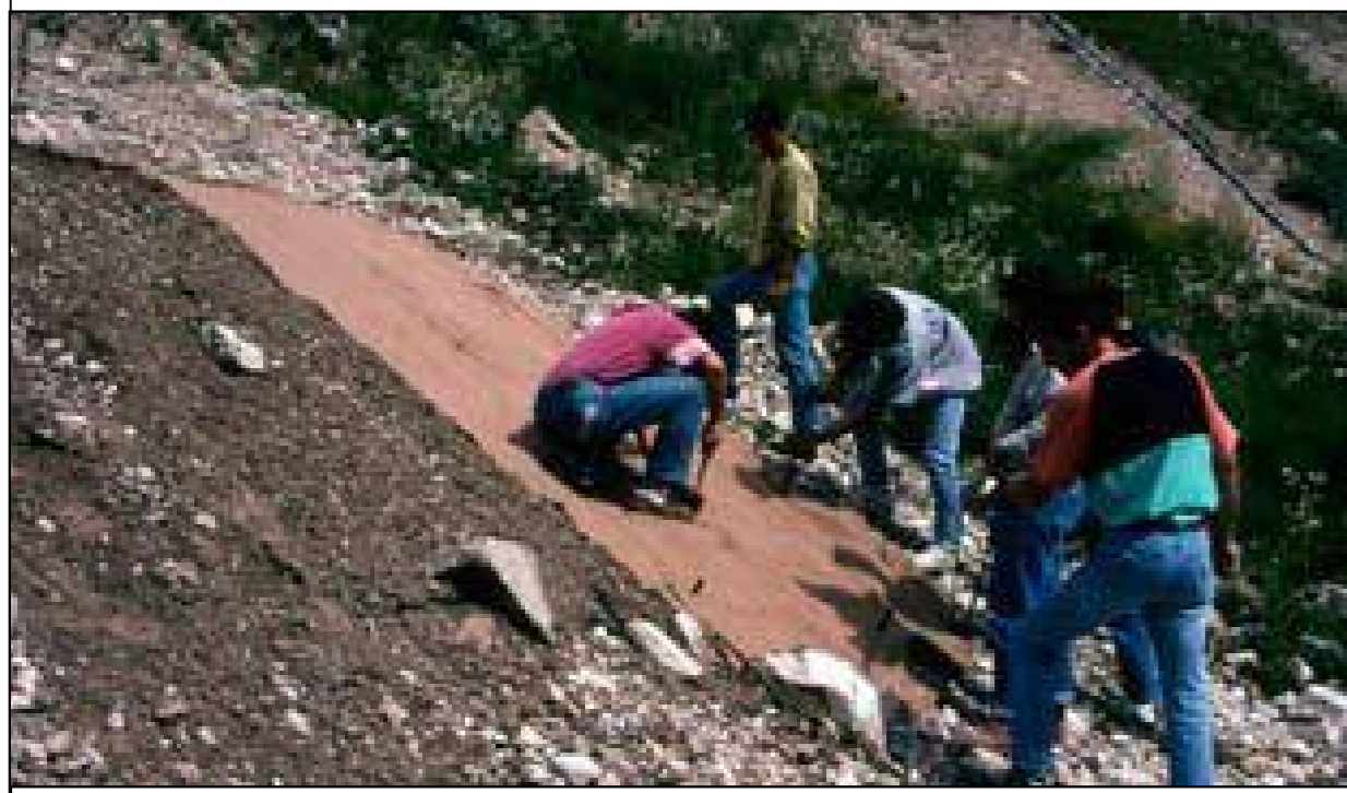
Rivestimento vegetativo in biofiltro di cocco, in opera
