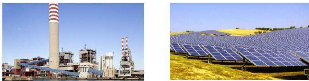
Figura 10 Confronto tra Centrale termica e Campo agrivoltaico
