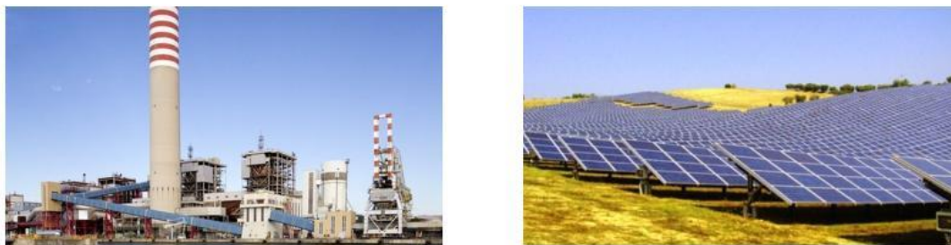
Figura 8 Confronto tra Centrale termica e Campo agrivoltaico
