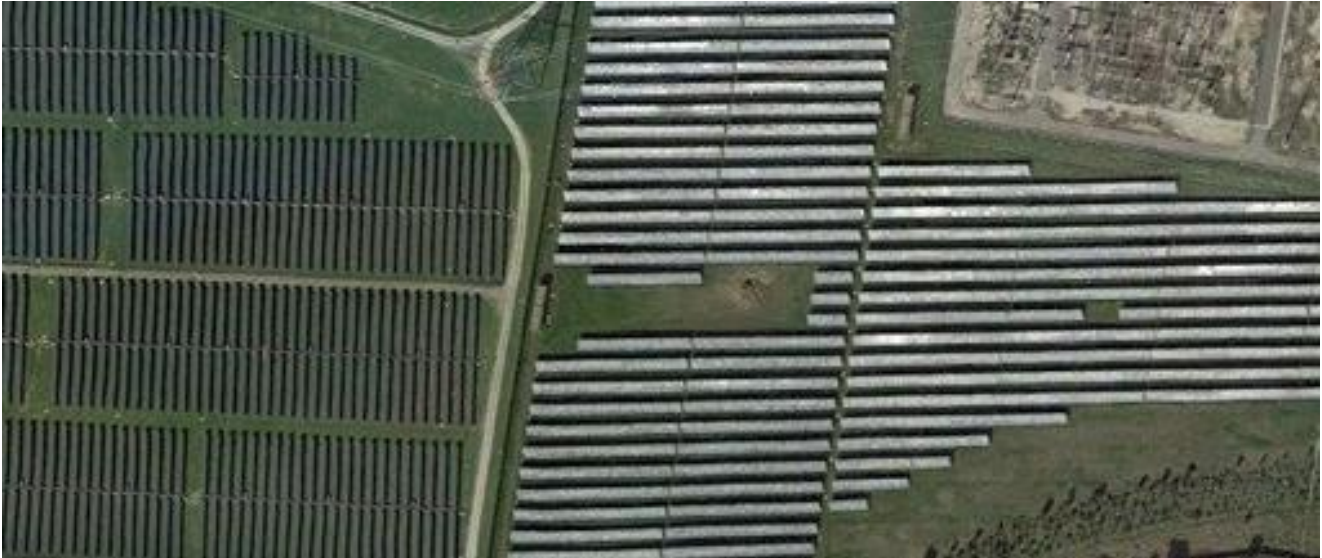
Figura 9 - Confronto impianti fotovoltaici a diversa tecnologia.
