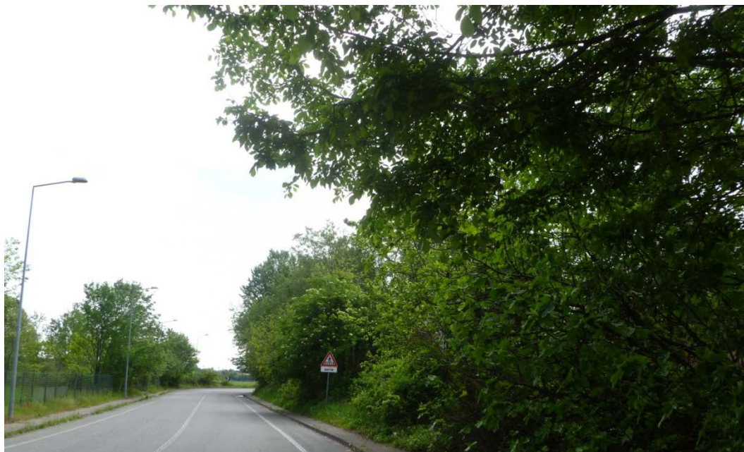
Figura 3.22 – Margine nord dell'unità presente a sud della via Edison, in affaccio alla strada.
