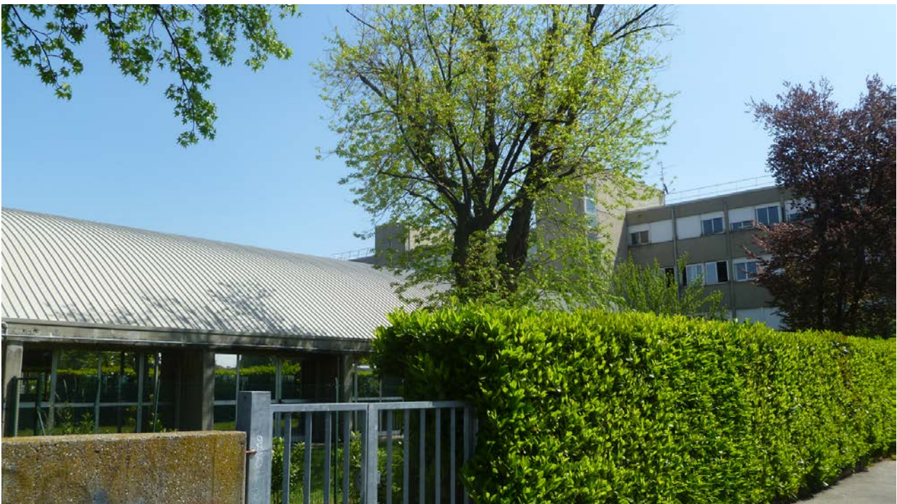
Figura 3.10 – Unità ornamentali lungo i margini delle pertinenze insediative lungo via Gentili.
