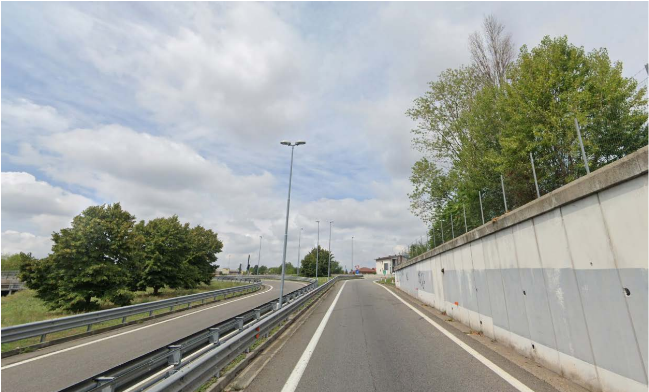
Figura 3.24 – Assetto vegetazionale ai lati della rampa di uscita dall'A52 allo svincolo con la SS36.
