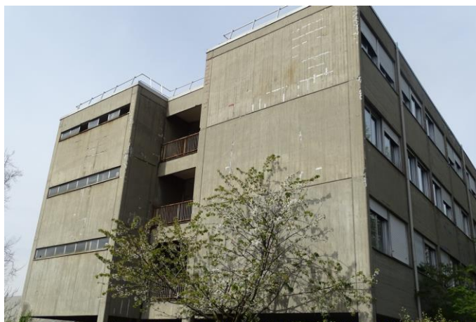
Figura 12-9: Edificio B013, immagine da sopralluogo.
