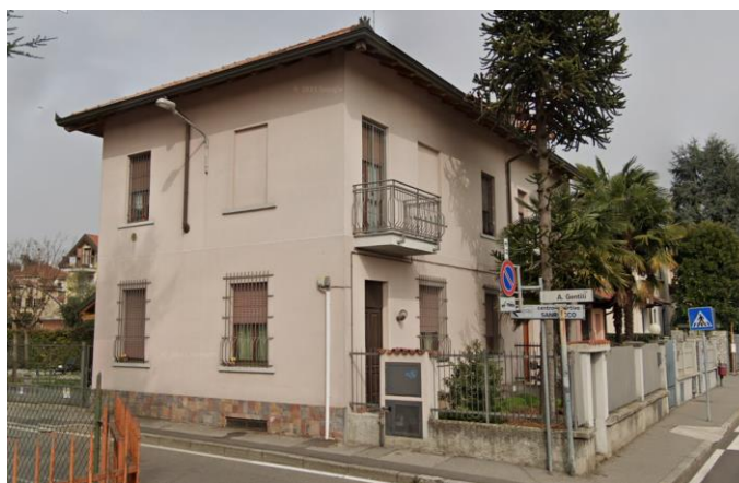
Figura 12-8: Edificio B006, immagine da sopralluogo.
