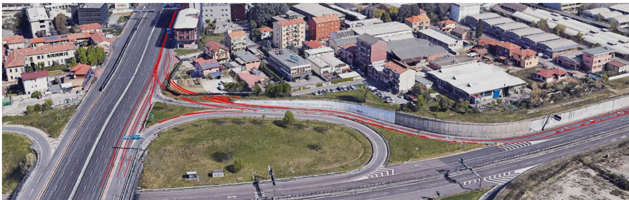
Figura 2.6 – Vista “a volo d’uccello” da sud dell’area dello svincolo A52-SS36 ove è previsto lo spostamento a lati della rampa di uscita esistente (fonte Google Earth)
