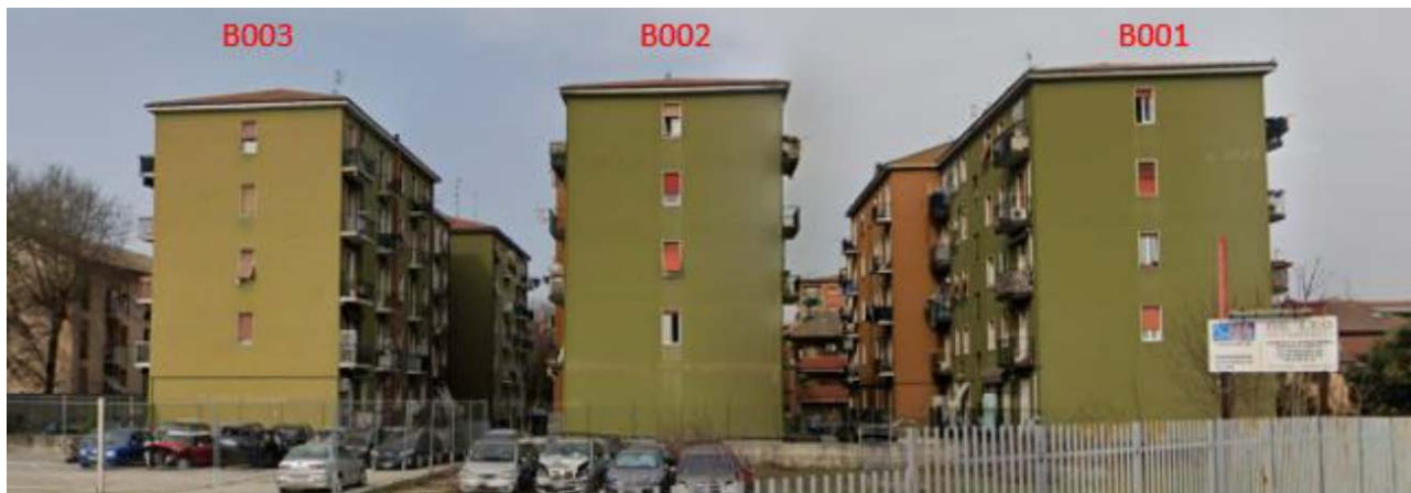
Figura 4.2 – Edifici B001, B002 e B003
