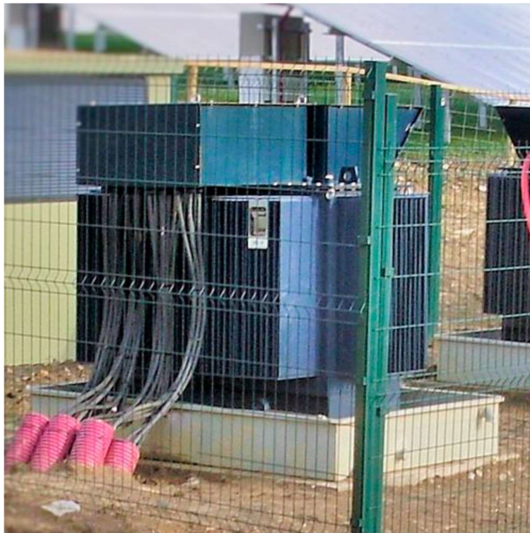
Figura 3 Esempio Vasca contenimento per trasformatore ad olio
