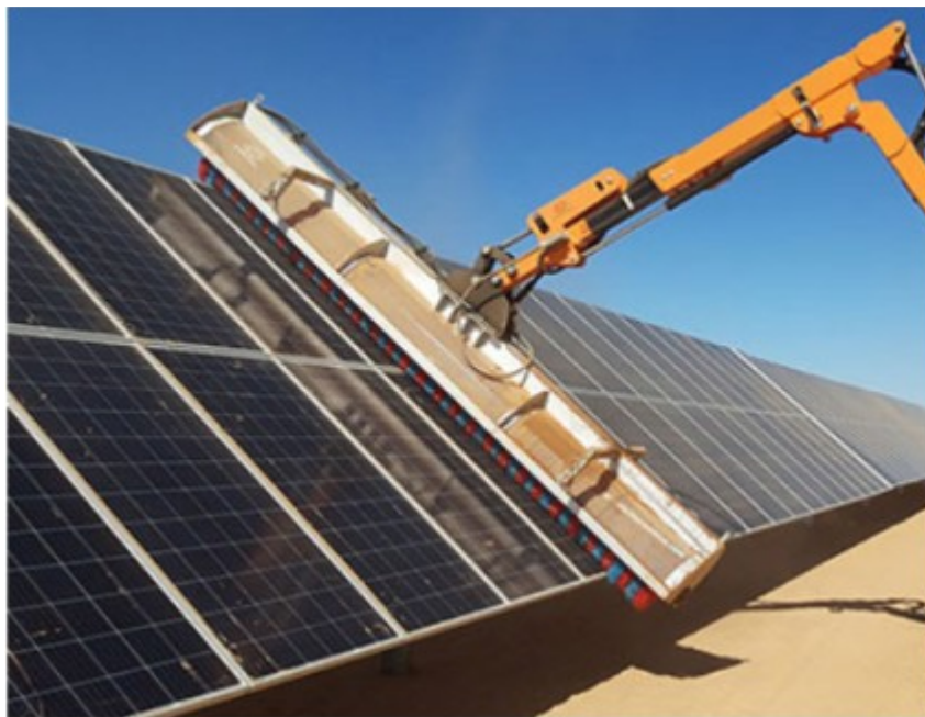
Figura 6: Esempio di pulizia mediante spazzola montata su braccio meccanico.
