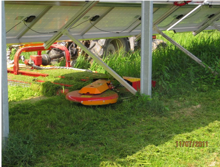
Figura 39: Sfalcio al di sotto dei pannelli sorretti da singolo palo centrale.
