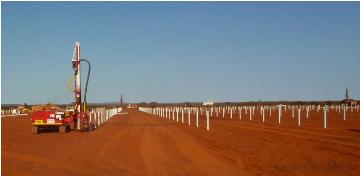
Figura 68: Infissione sostegni a mezzo di battipalo
