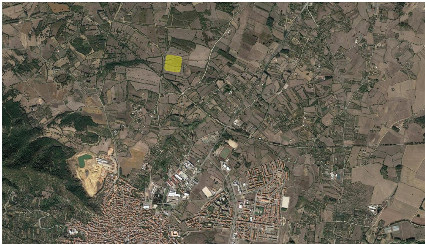
Figura 1: Ortofotocarta, in giallo l'area interessata dall'intervento di realizzazione della nuova S.E. di Guspini a nord del centro dell'abitato di Guspini.
