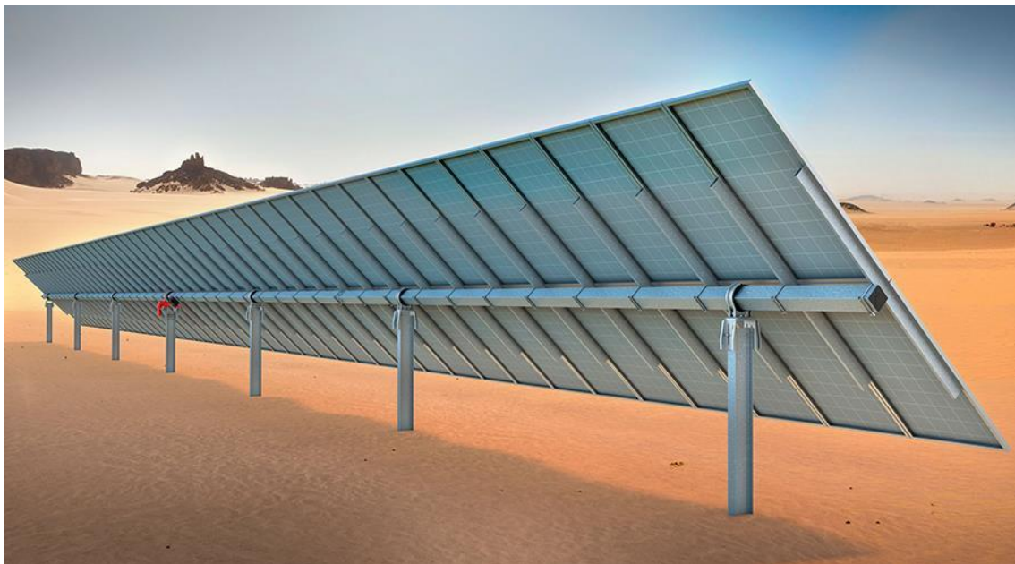
Figura 23: Immagine qualitativa della struttura di supporto
