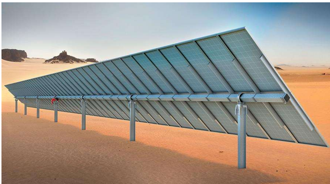
Figura 22: Immagine qualitativa della struttura di supporto
