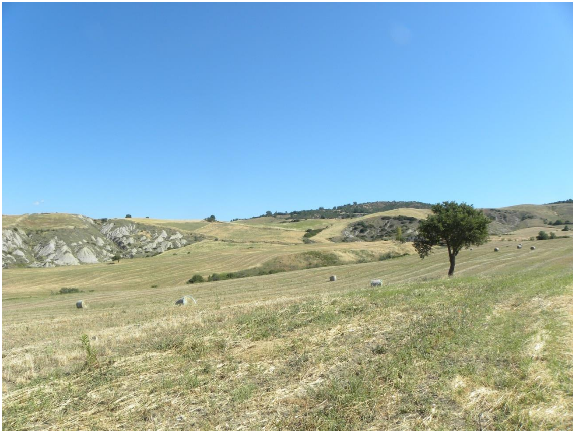
Figura 141: Veduta stato ante operam dalla strada comunale di accesso all'impianto
