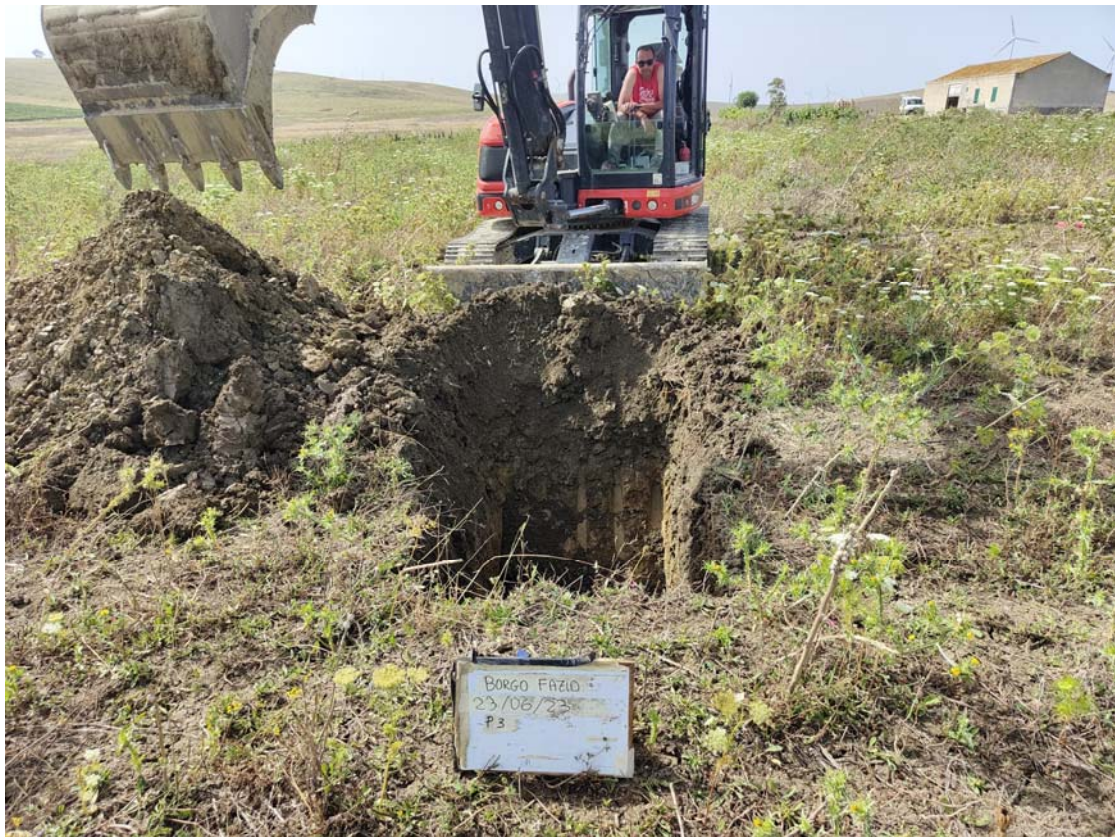
Pozzetto P3 postazione
