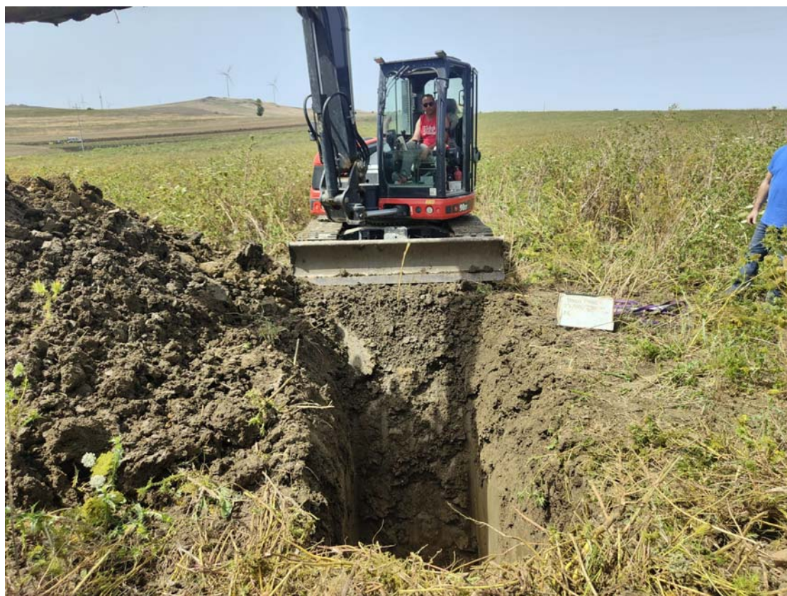
Pozzetto P4 postazione
