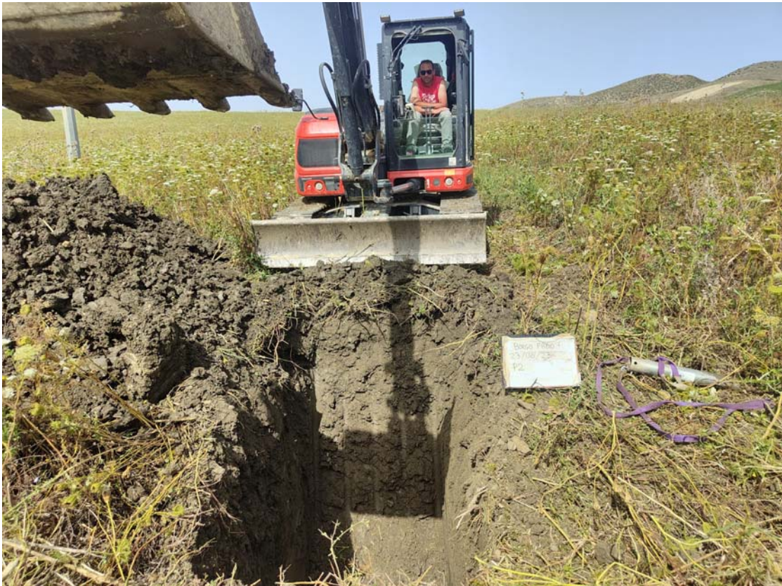
Pozzetto P2 postazione
