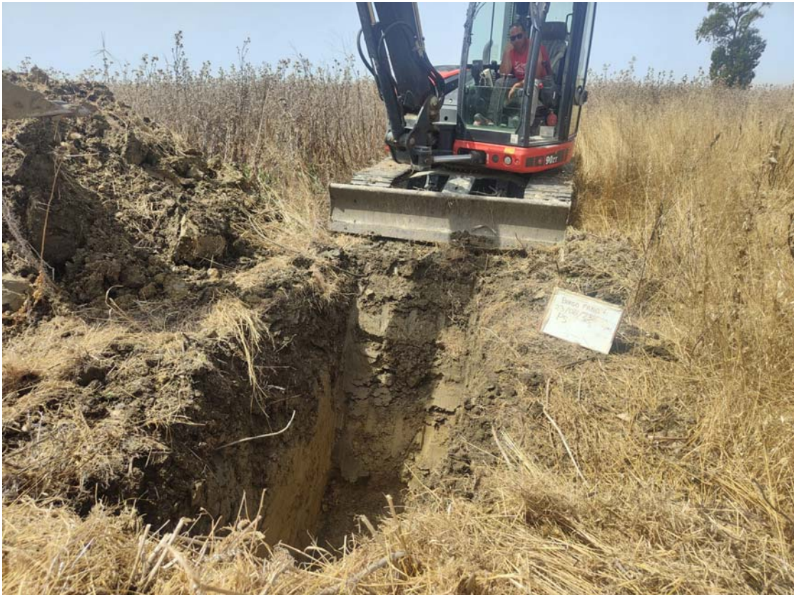
Pozzetto P5 postazione
