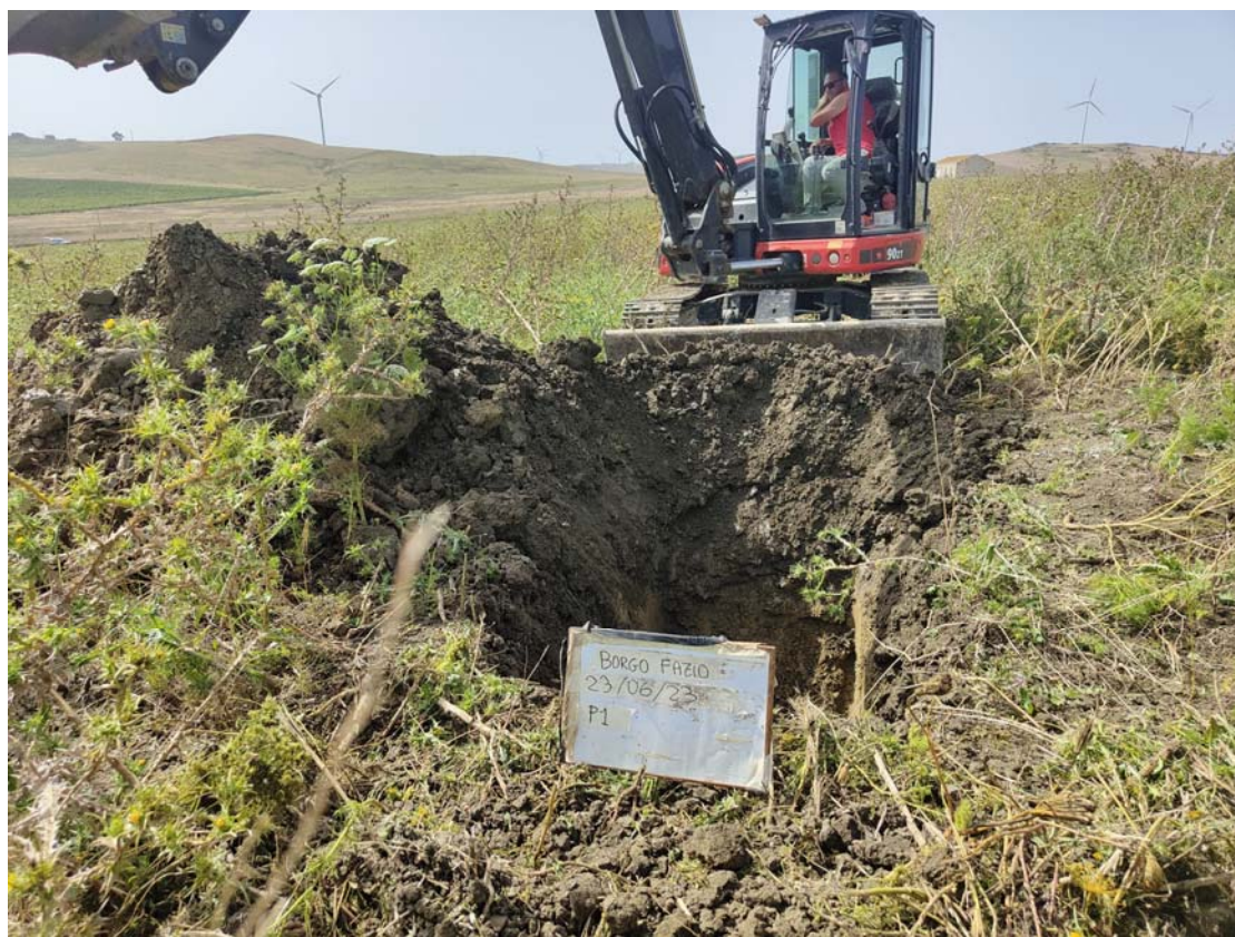
Pozzetto P1 postazione
