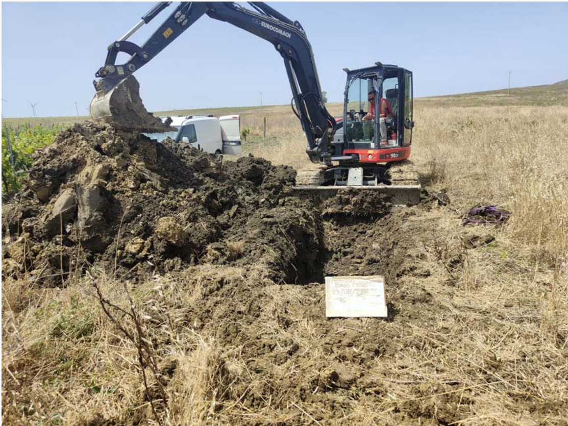
Pozzetto P6 postazione
