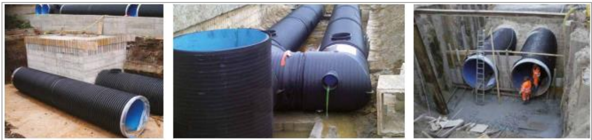
Figura 26- Esempi di tubazioni SGK.
