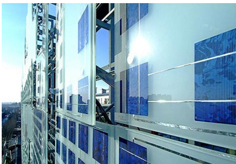
Figura 4 - Vetri fotovoltaici
