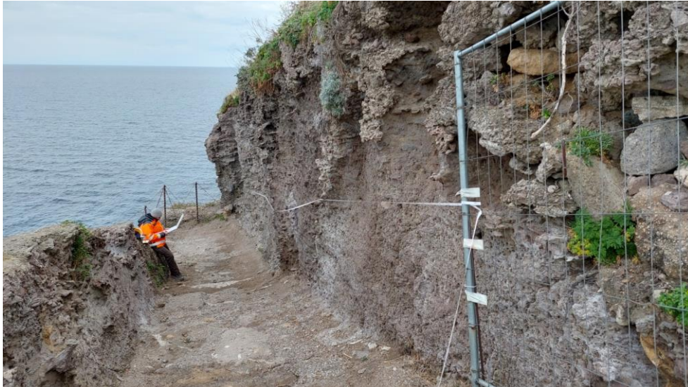
Figura 113 - Primo tratto del sentiero che dallo scalo Marinella conduce al carcere.
