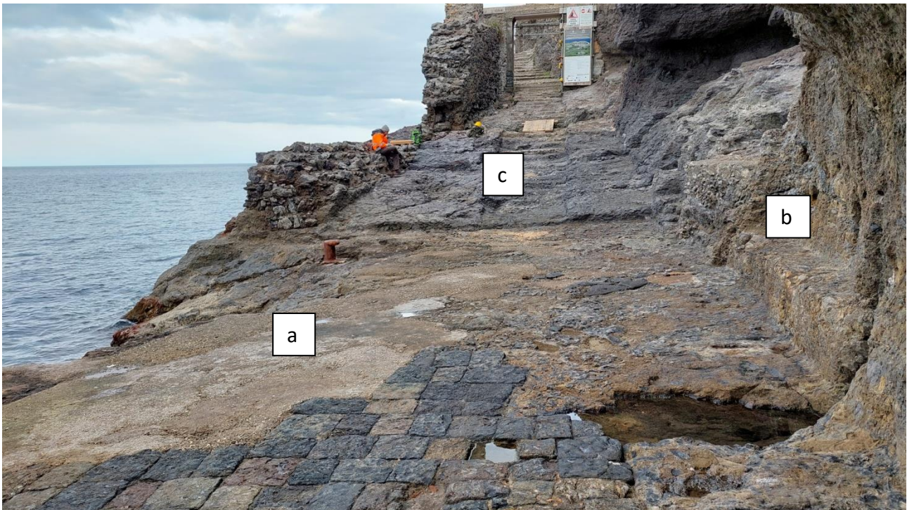
Figura 112 - Elementi antropici presso lo scalo Marinella. a) livellamento approdo e pavimentazione; b) sottoescavazione falesia; c) gradinata di accesso al sentiero per il carcere.
