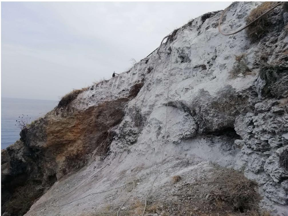
Fig.28 - Post operam - Vista dopo il disaggio del grande blocco individuato come instabile
