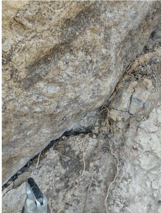
Fig. 27 - Particolare della frattura residua dopo il primo disaggio
