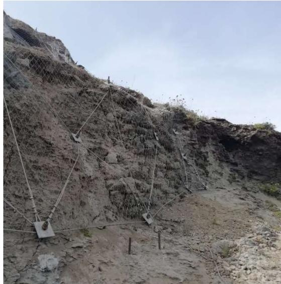
Fig. 29 -: Post operam: Intervento di mitigazione sul paramento murario con reti, funi e chiodi
