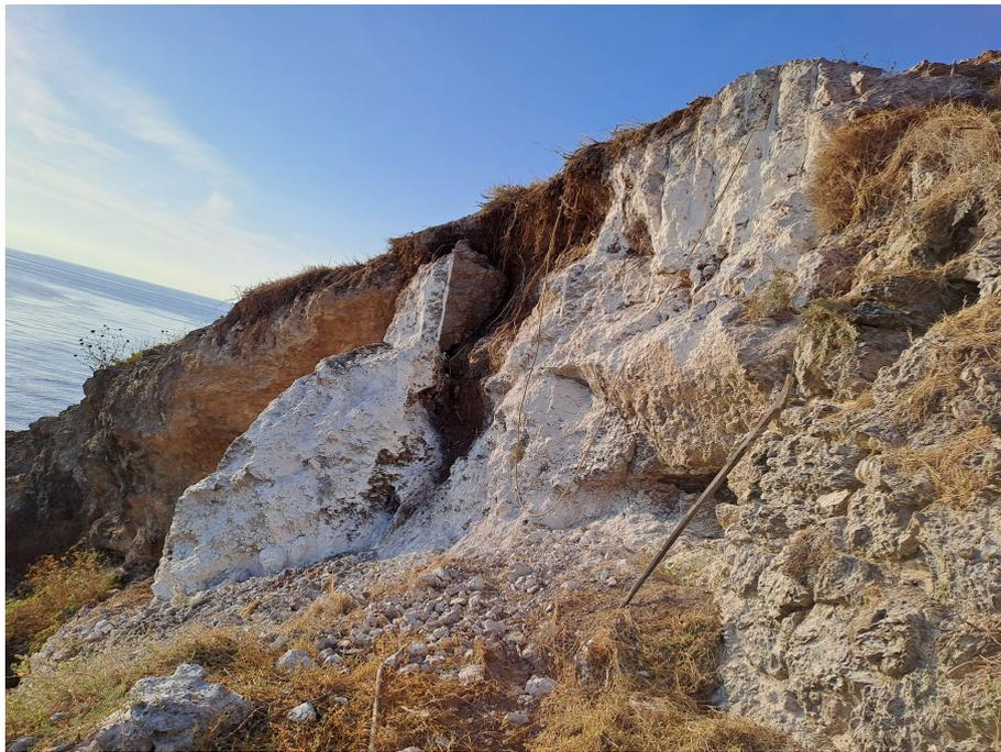
Fig. 26 - Post operam - Vista A dopo il primo disaggio effettuato con malte espansive
