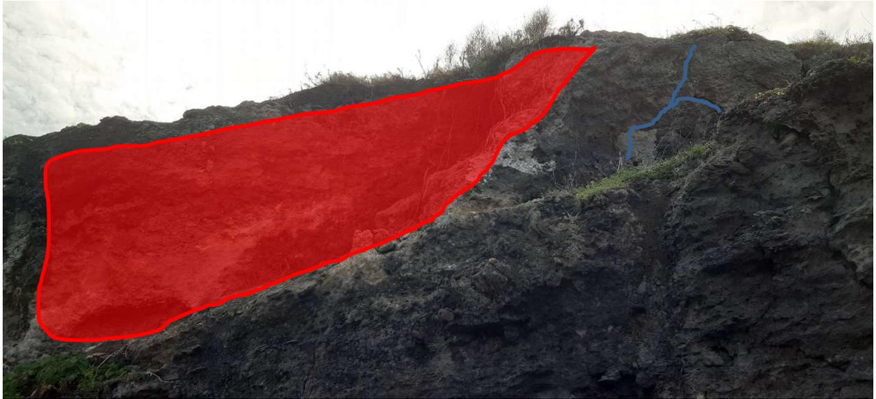
Fig. 25 - Ante operam - Vista B con evidenza delle fratture (blu) e della superficie di un precedente distacco (rosso)
