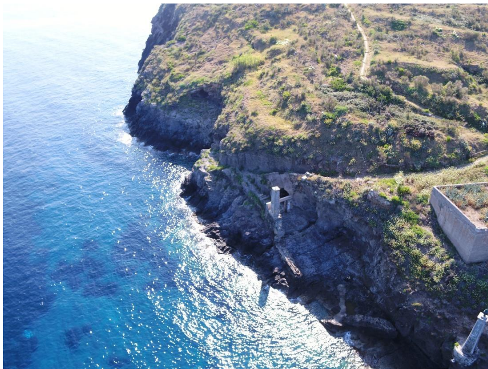
Foto 1 (sopralluogo 2020) – Scalo della Marinella
