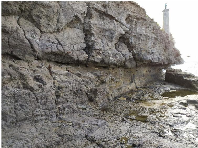
**Foto 3: Zona A stato attuale - Cavità antropica da chiudere per sottomurazione e falesia fessurata da stabilizzare tramite chiodature**
