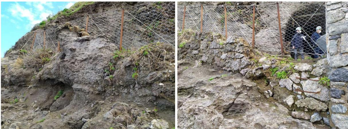
**Figura 6. Zona B stato attuale - Muro e roccia sottostanti il percorso Marinella, con evidenza di dissesti locali**
