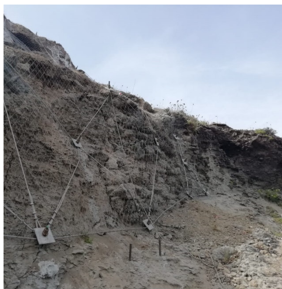
Foto 10: Post opera: Intervento di mitigazione sul paramento murario con reti, funi e chiodi
