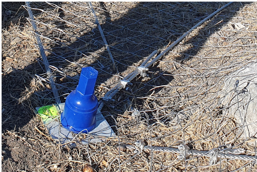
Figura 27: Particolare dettaglio di ancoraggio con rete, piastra, funi e calotta protettiva
