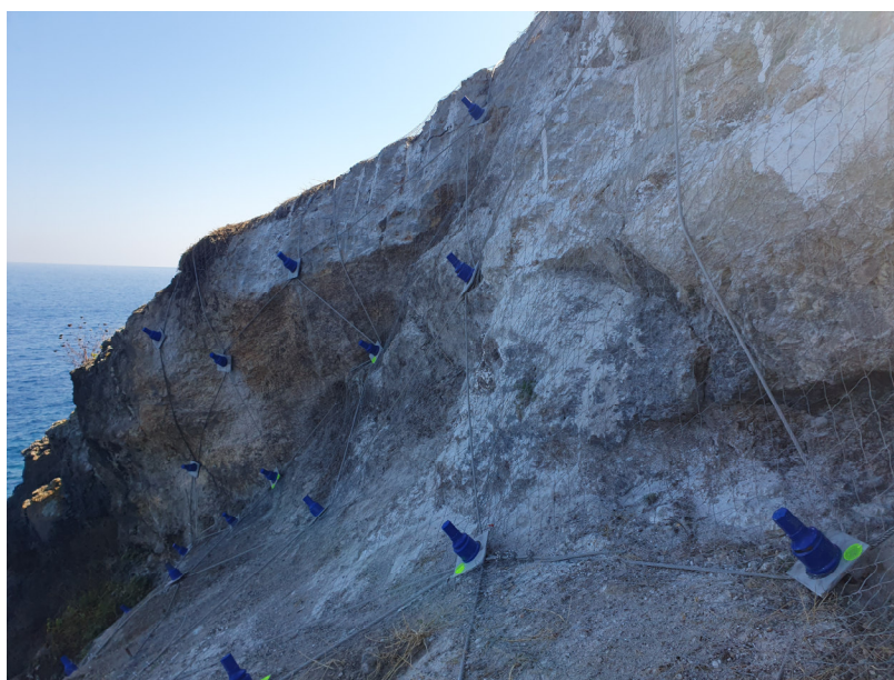
Figura 26: Zone 3 e 4 - Rete e barre di ancoraggio
