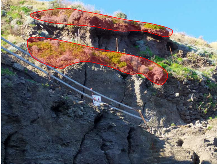
Figura 23: zona 1-2: Creste aggettanti zona 1-2 ante opera
