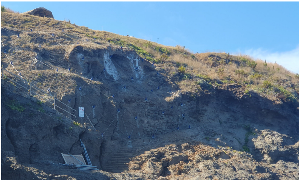
Figura 25: Zona 1 e 2: Rete e barre di ancoraggio
