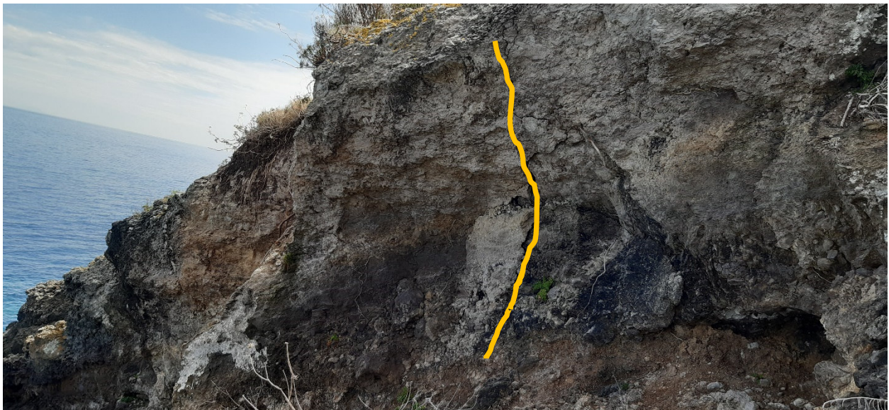
Foto 3: Ante opera - Vista A con evidenza delle fratture
