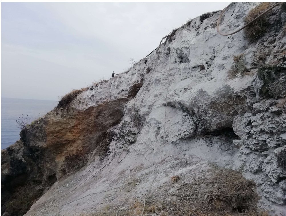
Fig.21 - Post operam - Vista dopo il disaggio del grande blocco individuato come instabile Sul muro che si presenta in stato di degrado si è eseguita la demolizione delle porzioni distaccate e poco cementate e, successivamente, si è applicata la rete in acciaio e barre di chiodatura.
