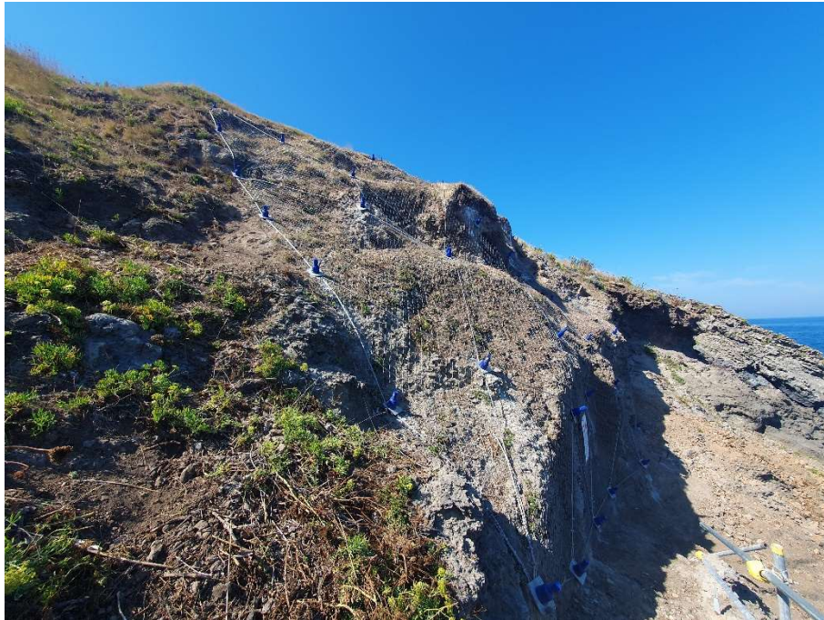
Fig. 23 - Post operam disgaggi aggetti in roccia – vista laterale
