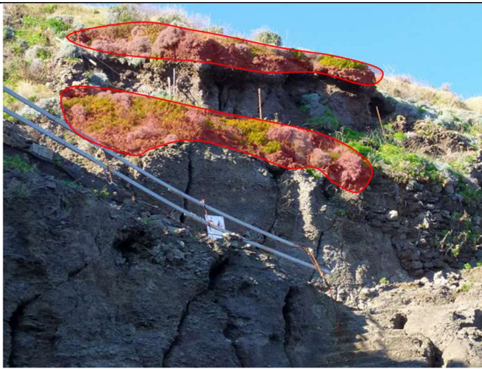
Figura 3: zona 1-2: Creste aggettanti zona 1-2 ante opera
