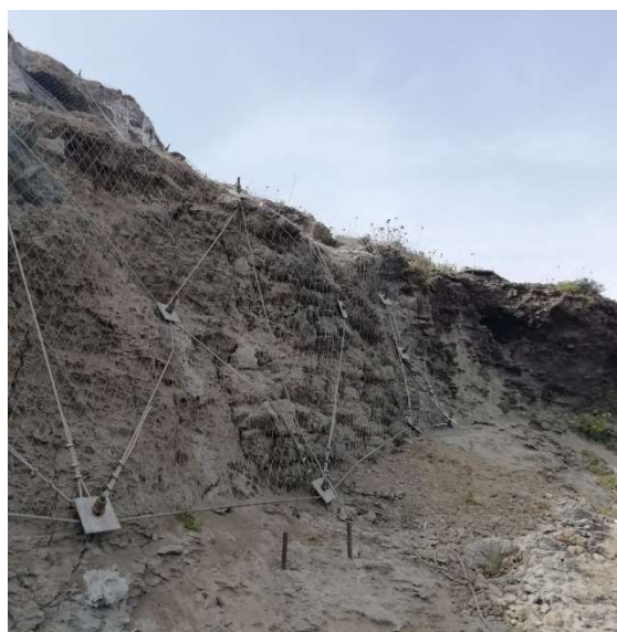
Fig. 22 -: Post operam: Intervento di mitigazione sul paramento murario con reti, funi e chiodi
