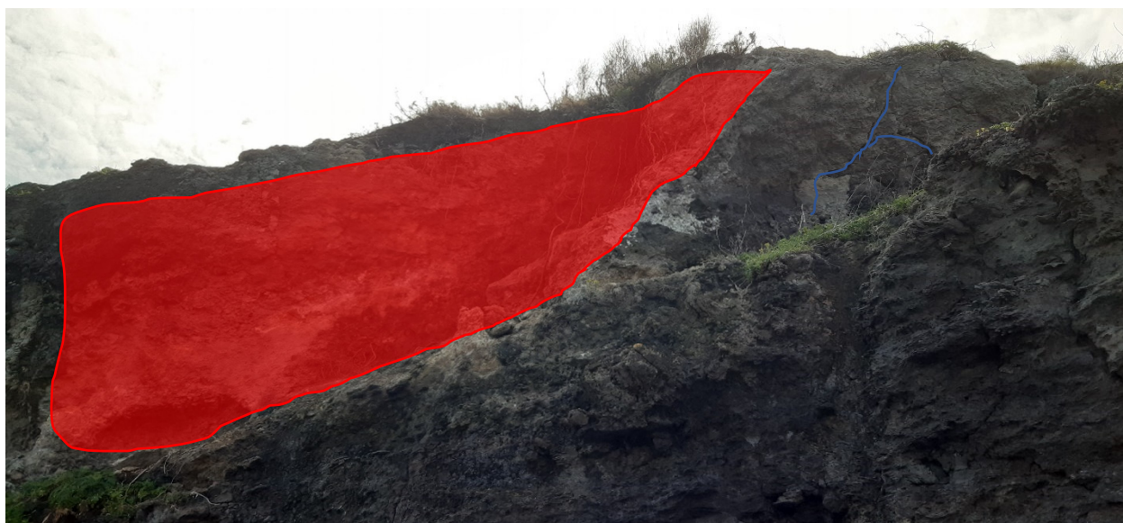
Foto 4: Ante opera - Vista B con evidenza delle fratture (blu) e della superficie di un precedente distacco (rosso)
