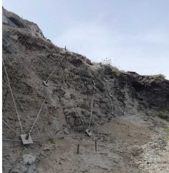
Foto 8: Post opera: Intervento di mitigazione sul paramento murario con reti, funi e chiodi
