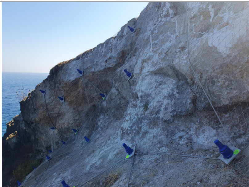
Figura 21: Zone 3 e 4 - Rete e barre di ancoraggio
