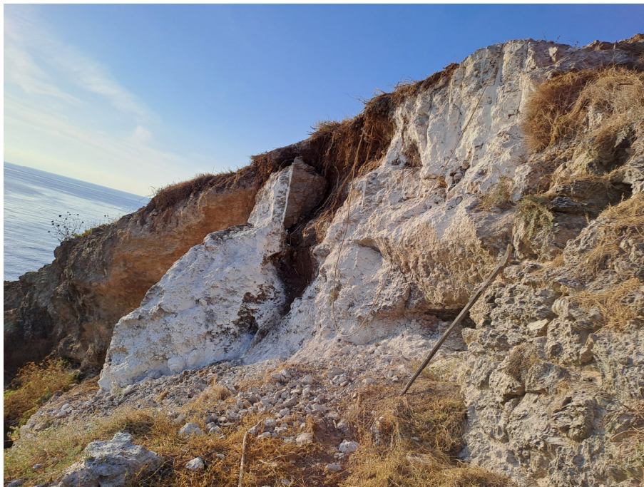
Foto 5: Post opera - Vista A dopo il primo disaggio effettuato con malte espansive
