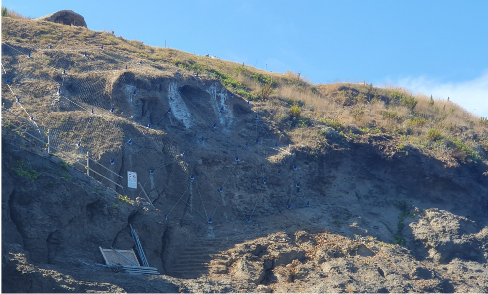
Figura 20: Zona 1 e 2: Rete e barre di ancoraggio
