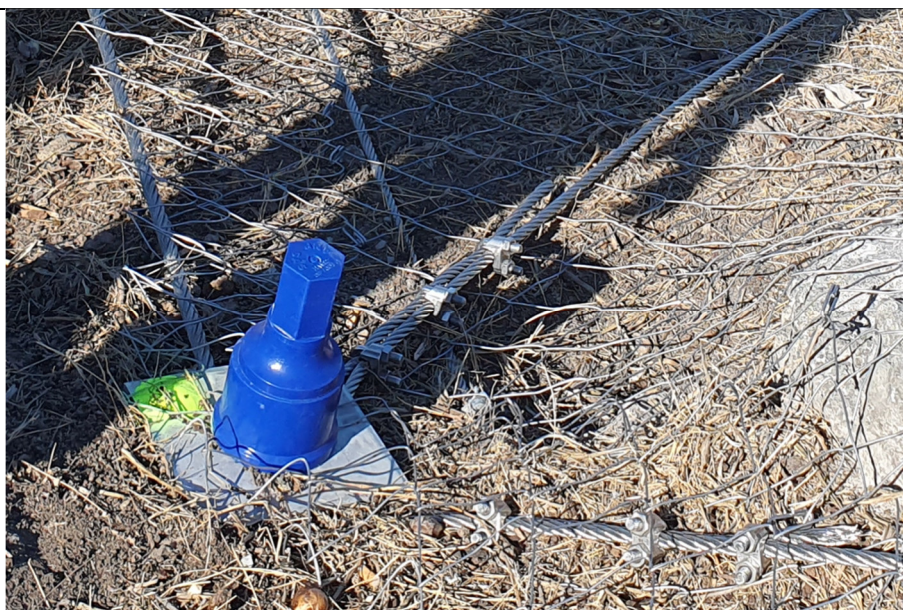
Figura 22: Particolare dettaglio di ancoraggio con rete, piastra, funi e calotta protettiva
