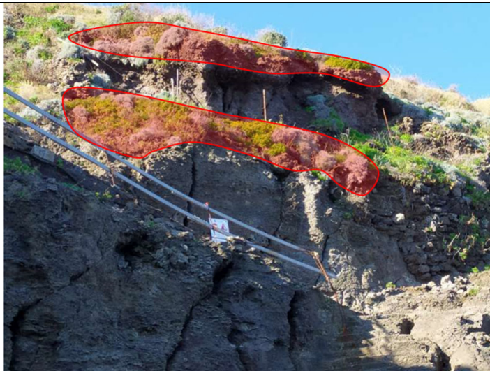
Figura 18: zona 1-2: Creste aggettanti zona 1-2 ante opera
