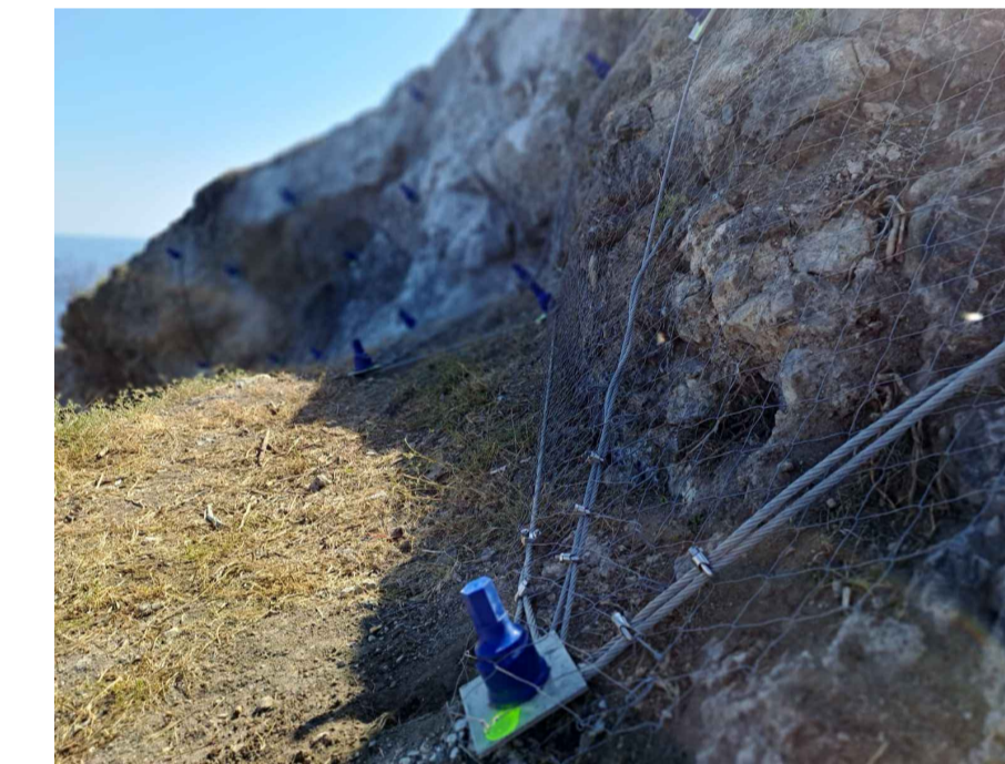
Foto dettaglio ancoraggio
