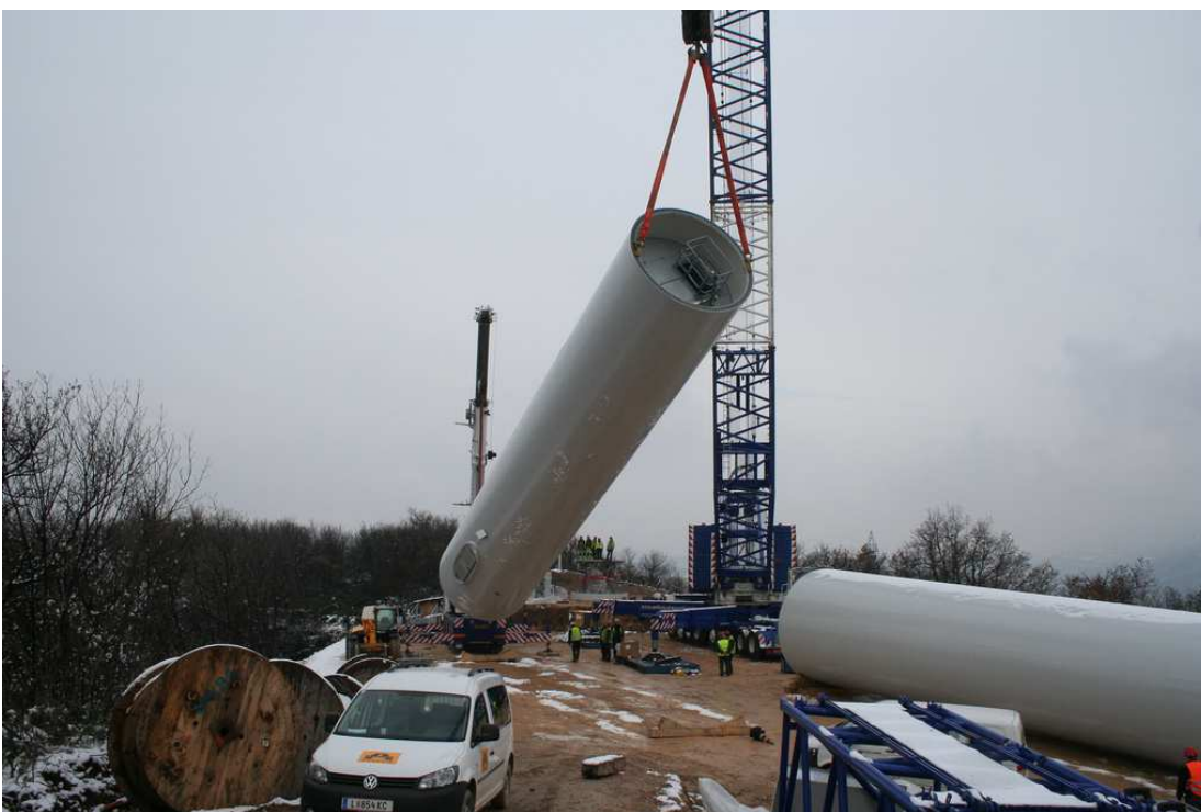
Figura 3. Smontaggio dei tronchi
