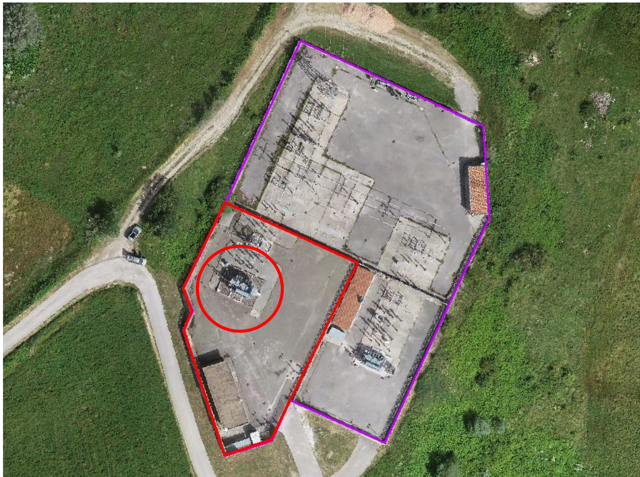
Figura 1. Posizionamento del trasformatore nella SSEU
