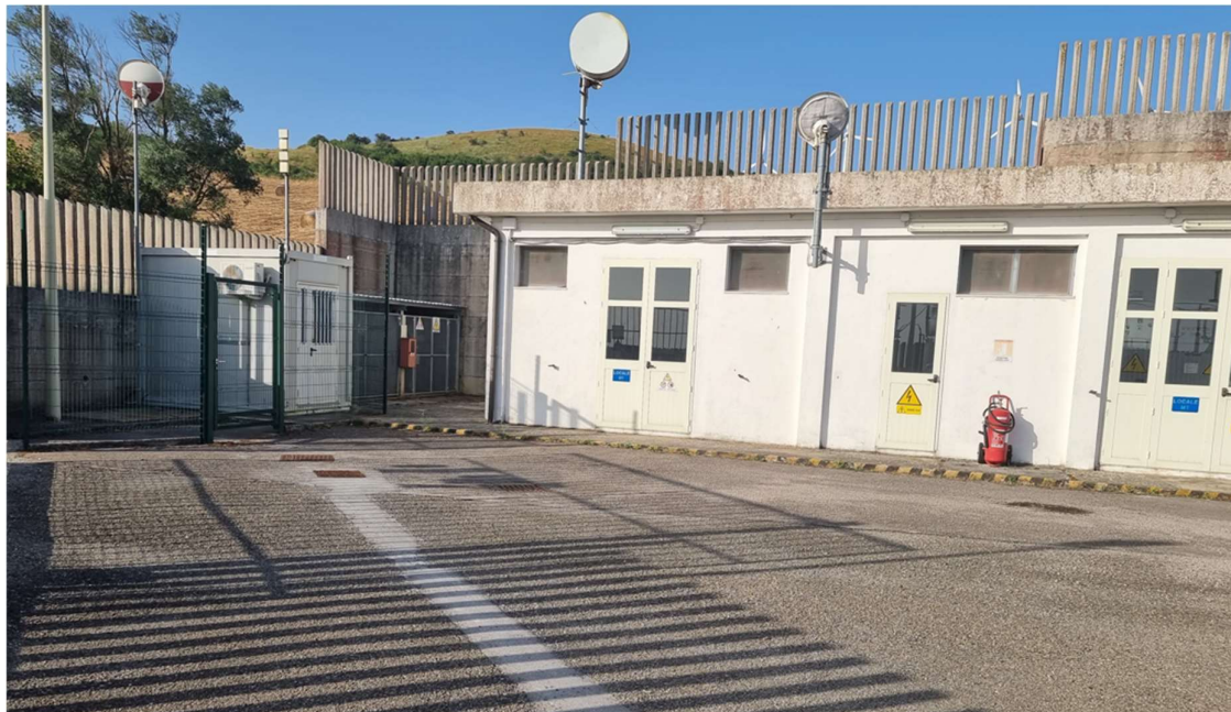
Fig. 2. Foto edificio locale tecnico esistente.
