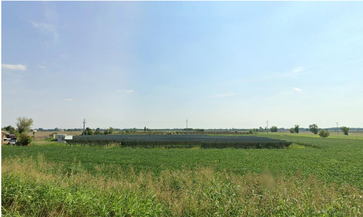
Figura 1 Impianto esistente di Arquà Polesine
