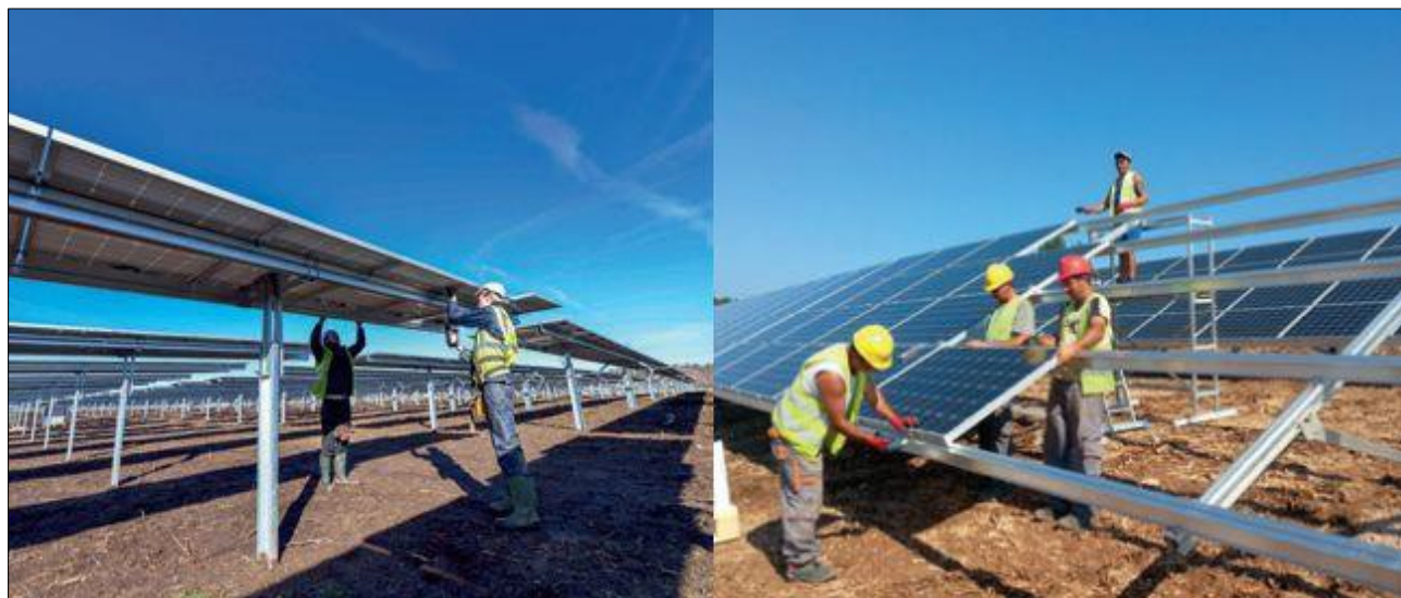
Figura 33: Montaggio tracker e moduli fotovoltaici
