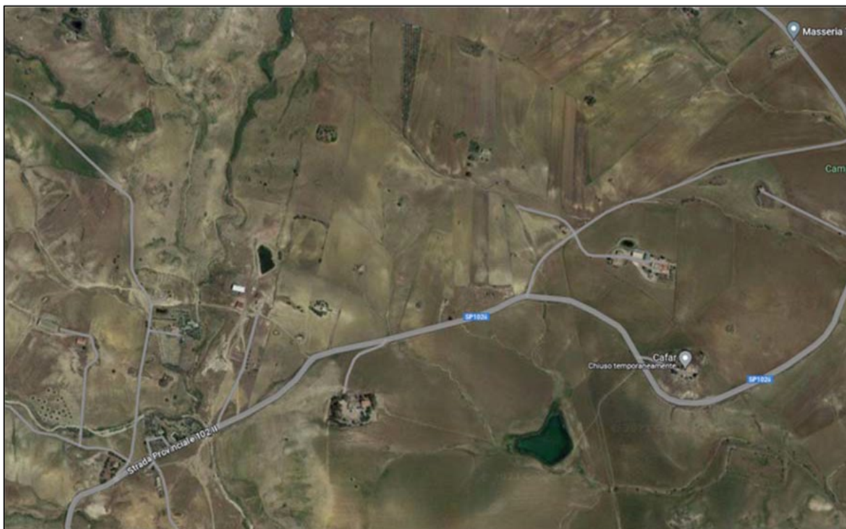
Figura 10: Partenza dell'elettrodotto AT in cavo interrato dalla SSE utente all'interno dell'impianto
