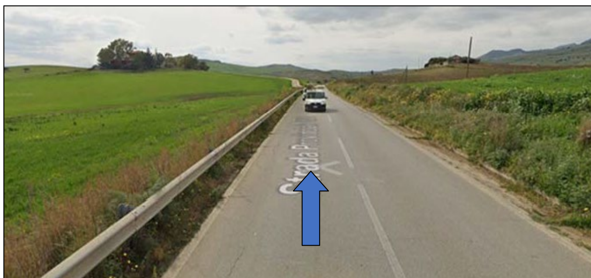
Figura 11: Percorso dell'elettrodotto AT in cavo interrato lungo la SP102ii, direzione Castel Di Iudica
