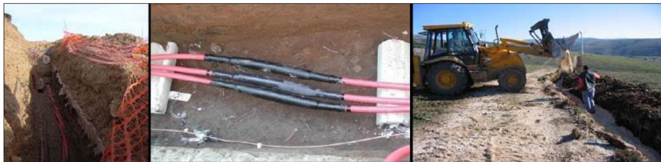
Figura 34: Scavo con posa cavi Posa rete di terra
