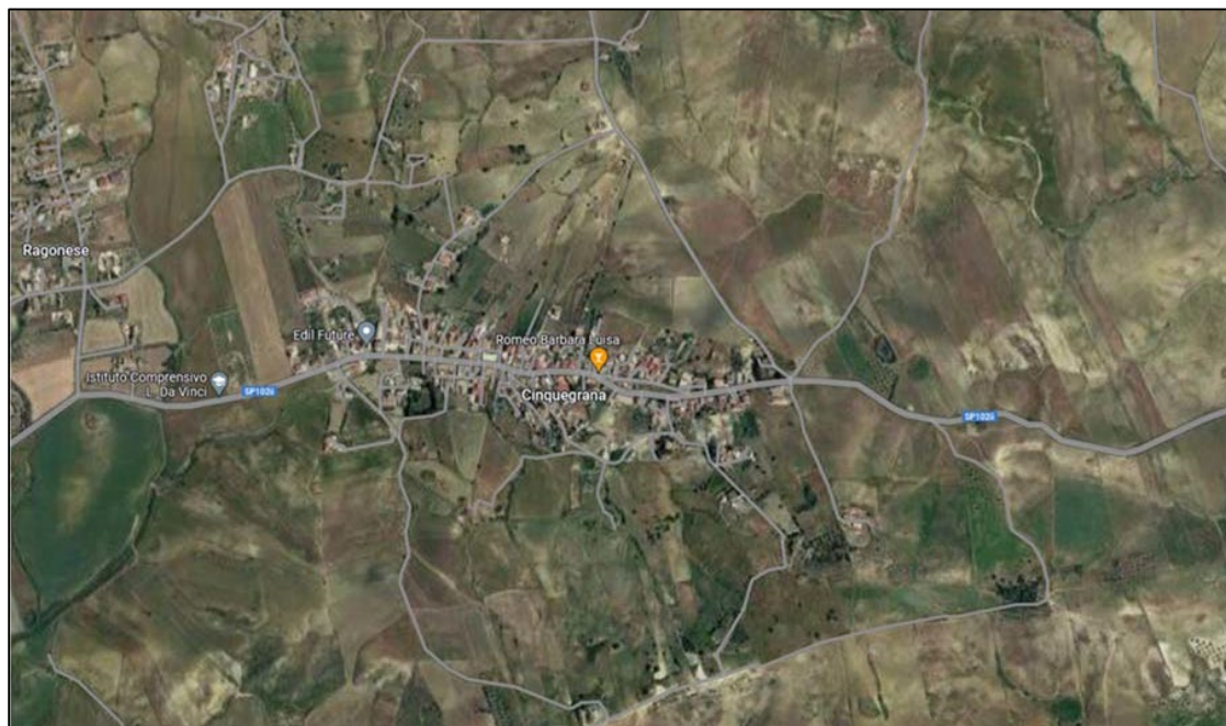
Figura 15. Percorso dell'elettrodotto AT in cavo interrato che oltrepassa la frazione Cinquegrana, territorio del comune di Castel Di Iudica.
