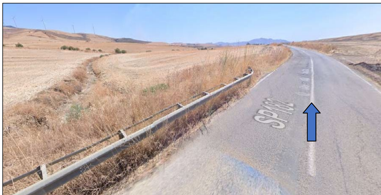
Figura 20. Percorso dell'elettrodotto AT in cavo interrato in immissione nella SP182, direzione Raddusa
