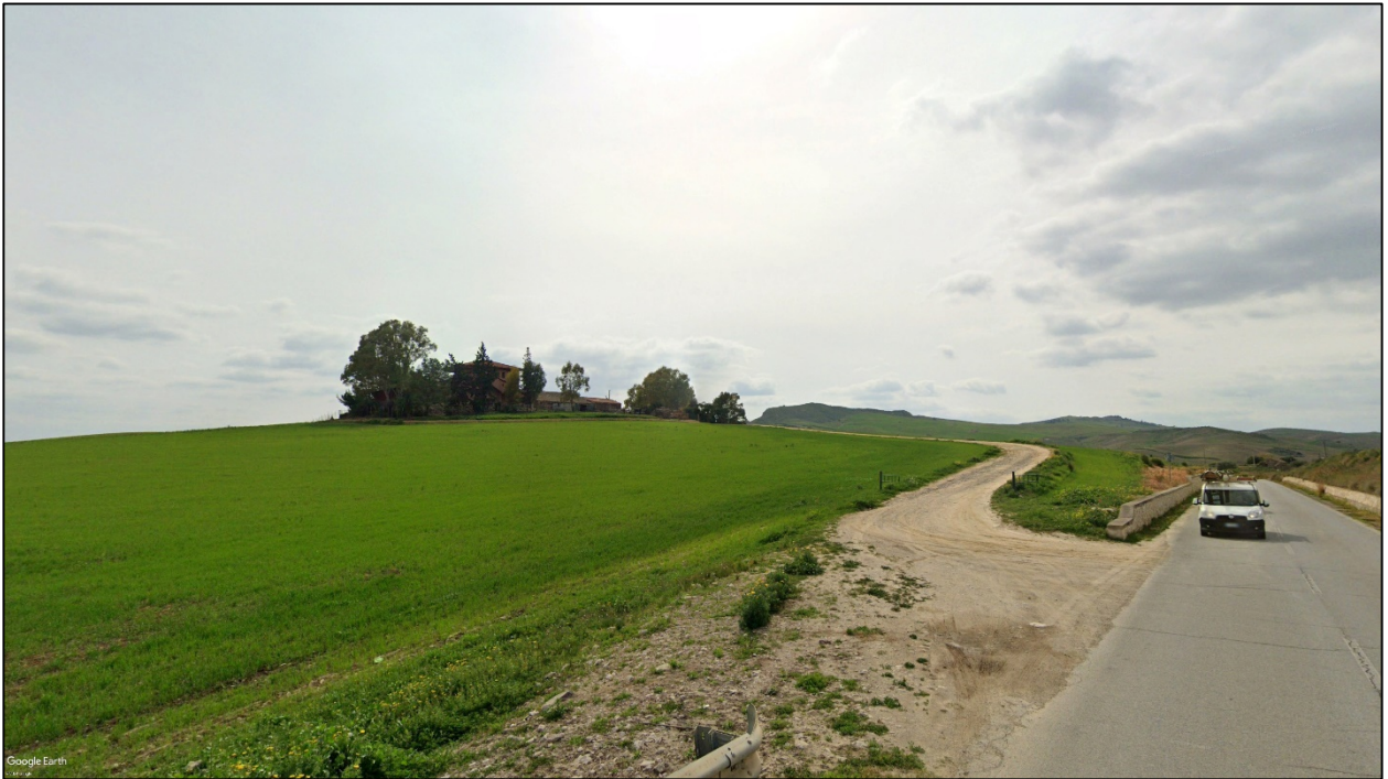
Figura 18 – Veduta della Masseria Giunta dalla S.P.102 II.
