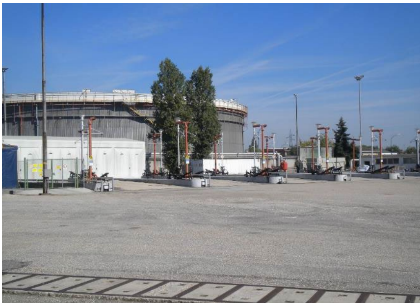
Figura 11: Rampe di scarico autobotti
